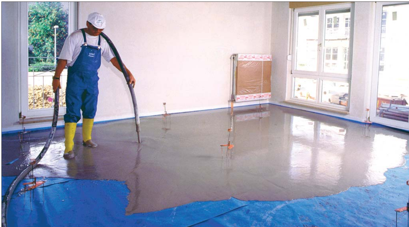
Заливка пола
