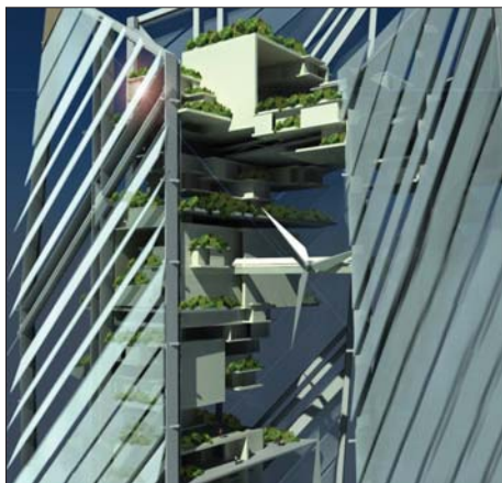
Турбины и жалюзи для обеспечения небоскреба электроэнергией
