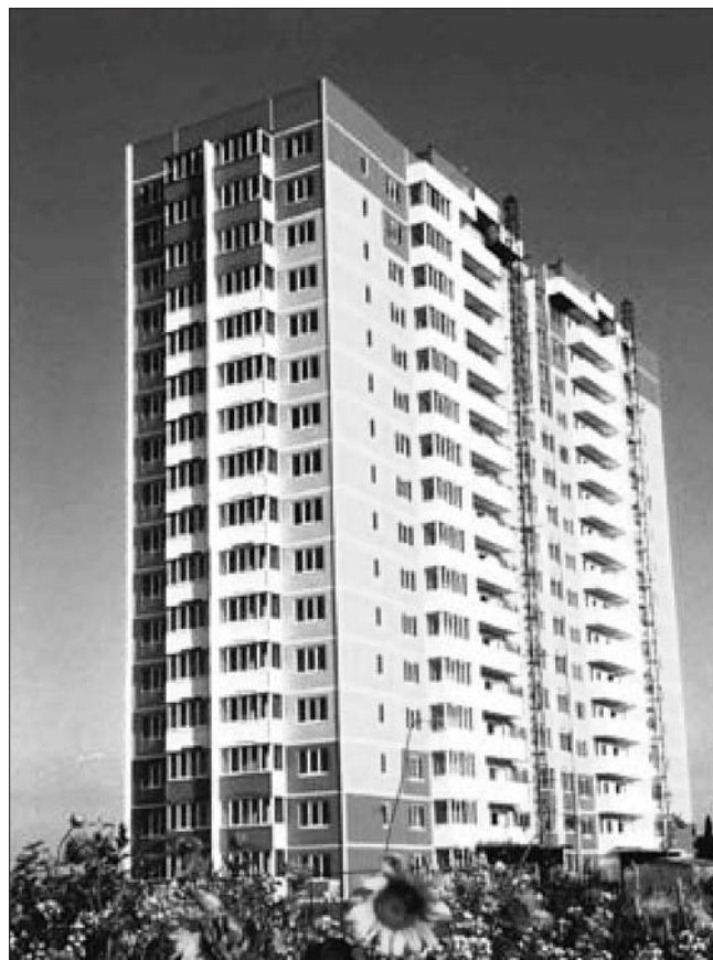
Рис. 4. Объемно-блочное домостроение в Краснодарском крае
