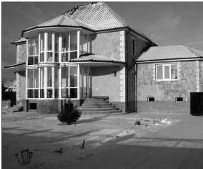
Рис. 3. Коттеджное строительство на основе керамзитобетонных блоков. Пос. Ягодное (40 км от г. Тольятти Самарской обл.)
