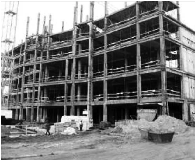
Рис. 1. Монолитное строительство здания гостиницы на основе керамзитобетона (Нижний Новгород)
