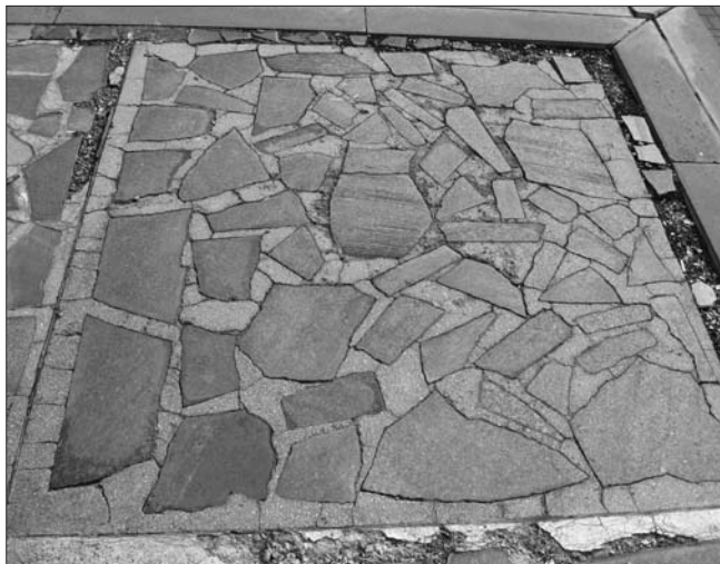
Рис. 1. Пол из бетона с фиксированным крупным заполнителем
