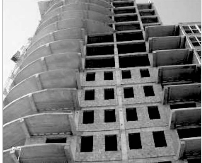
Рис. 2. Высотное жилое здание с применением керамзитобетонных блоков (Нижний Новгород)
