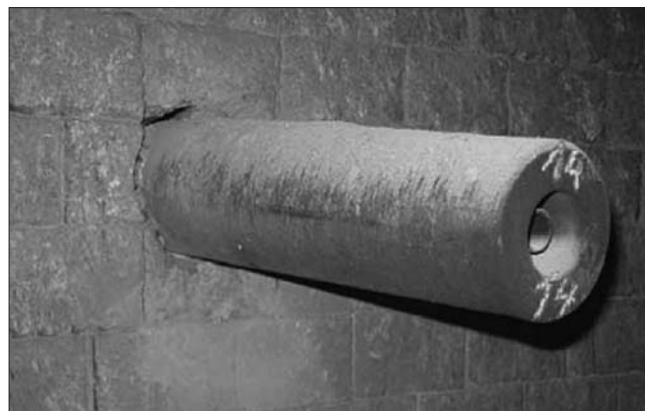
Рис. 2. Подвижные боковые горелки с жидкостным охлаждением
