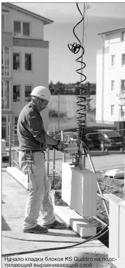
Стена из крупноформатных блоков
