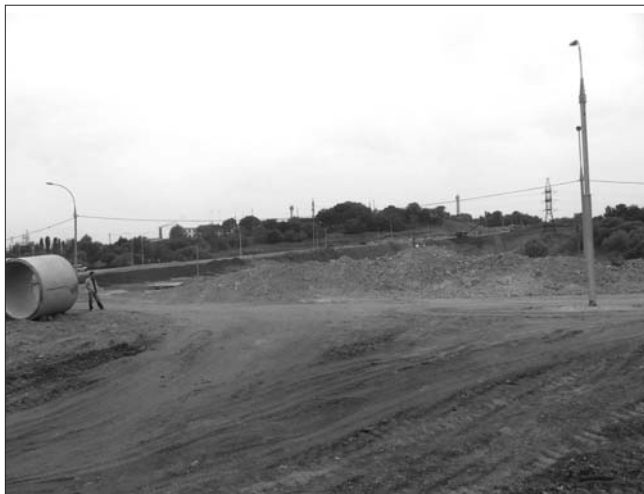
Строительство обьездной дороги в Липецке
