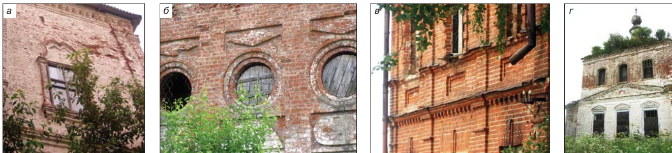
Рис. 4. Примеры высокой прочности каменной кладки зданий XVIII–1-й пол. XIX в. южной части Череповецкого и Шекснинского районов: а – церковь Рождества Богородицы в с. Чуровское (1765 г.); б – Михаило-Архангельская церковь в с. Архангельское (1809 г.); в – Успенская церковь в с. Воронино (1804 г.); г – Троицкая церковь в с. Дмитриевское (1835 г.)
