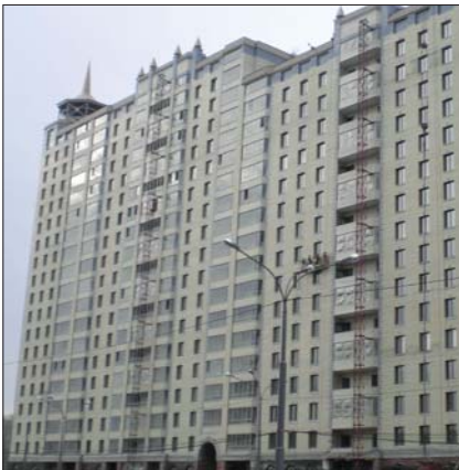
Рис. 1. Офисно-жилой комплекс в Екатеринбурге на ул. Белинского, построенный из глазурованного кирпича однократного обжига
