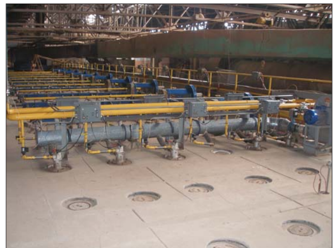
Рис. 5. Пример установки сводовых горелок фирмы «Кромшрёдер» на Норском керамическом заводе (Ярославль)
