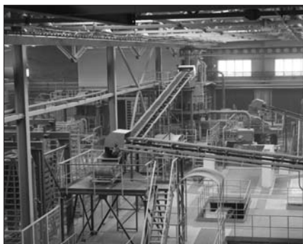
Рис. 2. Участок подготовки глинистого сырья
