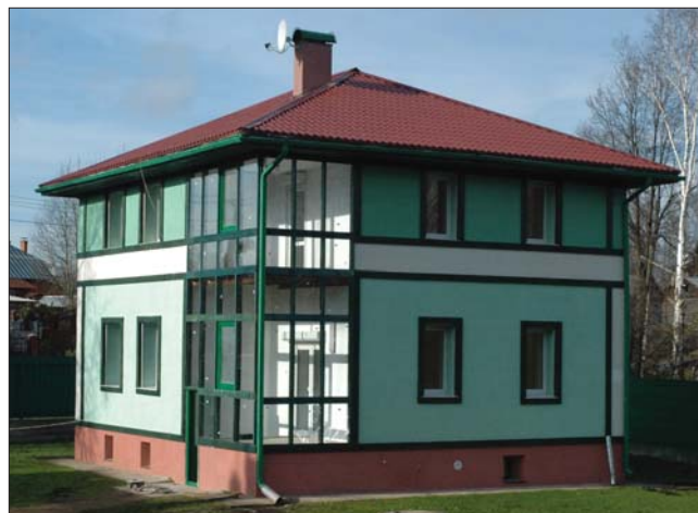
Рис. 3. Дом в Подмоскowie, реконструированный с использованием эковаты
