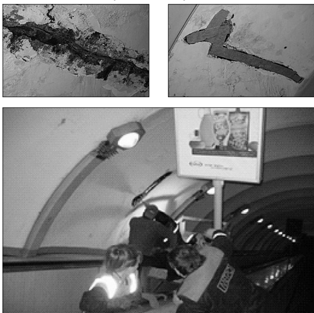
Рис. 7. Санация трещин свода. Метрополитен в Санкт-Петербурге
