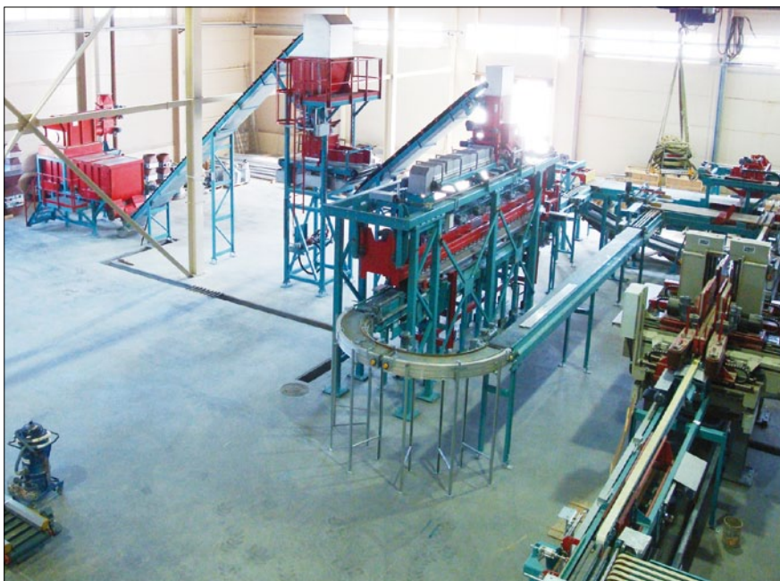
Линия шлифования и линия заполнения пустот изделий минеральной ватой по методу CORISO
