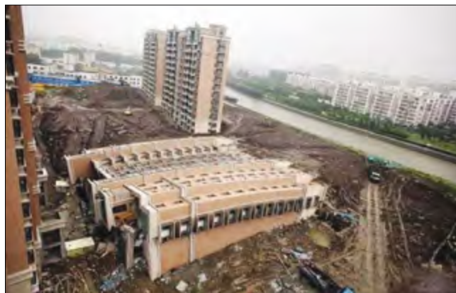
Рис. 1. Обвал многоэтажного дома «Лотус-Риверсайд» в результате землетрясения в Шанхае
