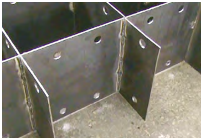
Рис. 2. Листовой элемент узловой зоны железобетонной плиты в процессе сборки
