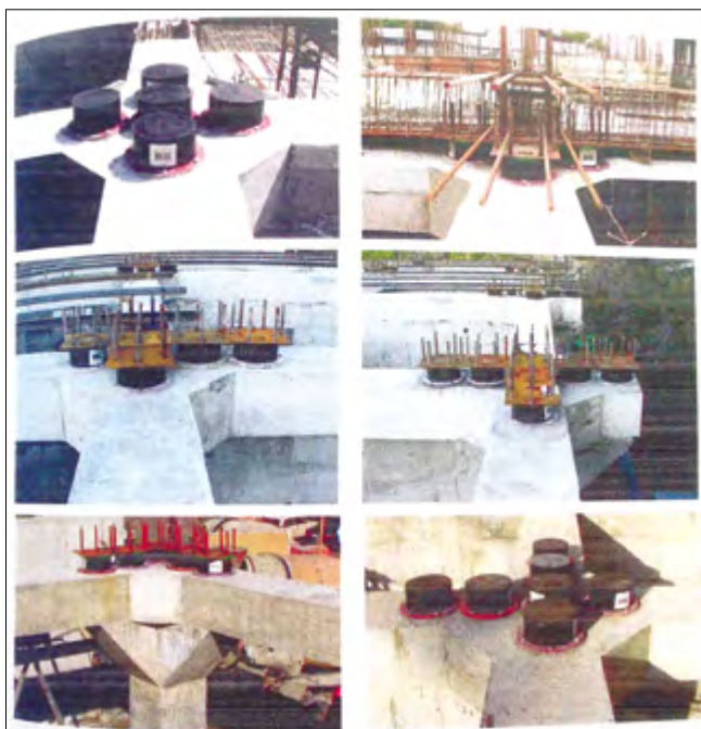
Рис. 3. Пример установки различного числа резинометаллических опор
