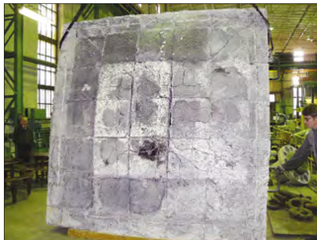
Рис. 5. Характер разрушения плиты с листовой арматурой
