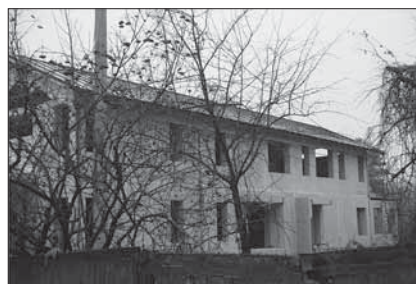
Рис. 3. Общий вид дома из пеногипсовых конструкций
