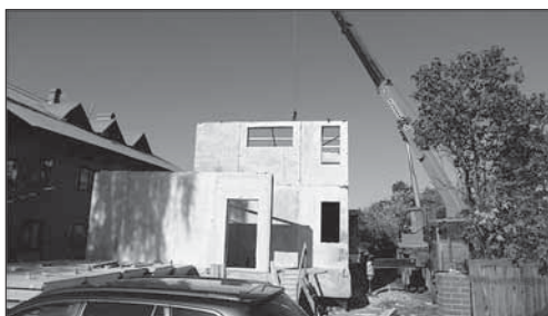
Рис. 1. Монтаж пеногипсовых конструкций
