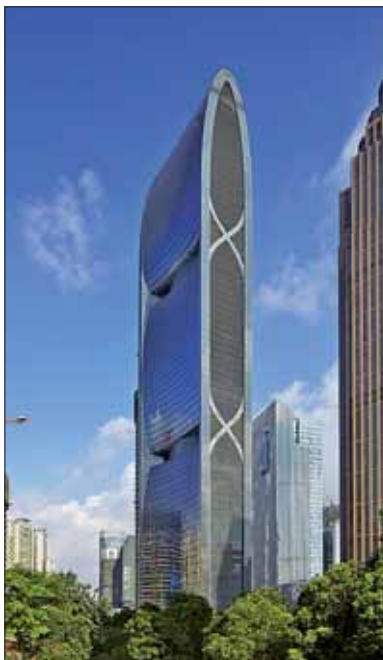
Рис. 4. Башня Жемчужной реки
