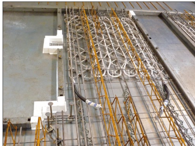
Рис. 1. Модуль трубопроводов и арматура в сборно-монолитном перекрытии
