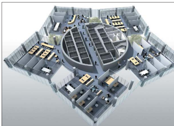
Пять квадратных в плане крыльев башни поэтажно поворачиваются относительно своих центров по спиральной траектории, уменьшаясь в размере по мере восхождения к вершине, создавая силуэт веретенообразного шпиля
