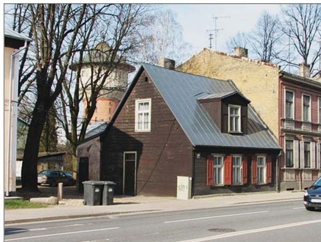
Рис. 4. Реконструированный дом по ул. Калнциема, 29
