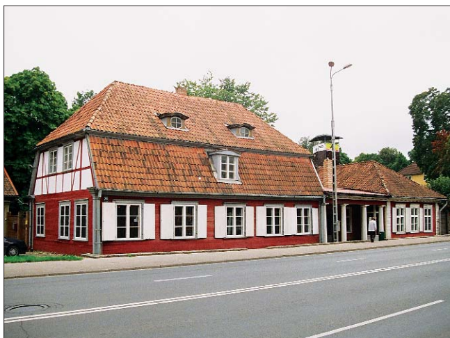
Рис. 5. Восстановленный фасад дома по ул. Калнциема, 28
