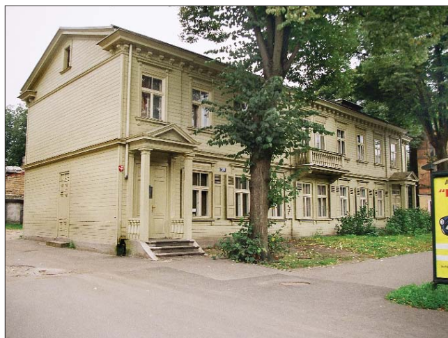
Рис. 2. Восстановленный деревянный дом по ул. Калнциема, 16
