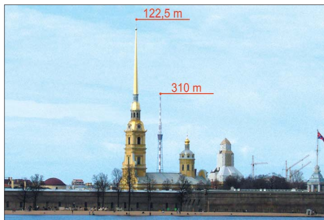
Так выглядит телебашня высотой 310 м, находящаяся на расстоянии около 3 км от Петропавловского собора, высота которого ниже более чем в 2,5 раза
