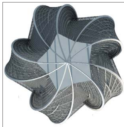
Пять квадратных в плане крыльев башни поэтажно поворачиваются относительно своих центров по спиральной траектории, уменьшаясь в размере по мере восхождения к вершине, создавая силуэт веретенообразного шпиля
