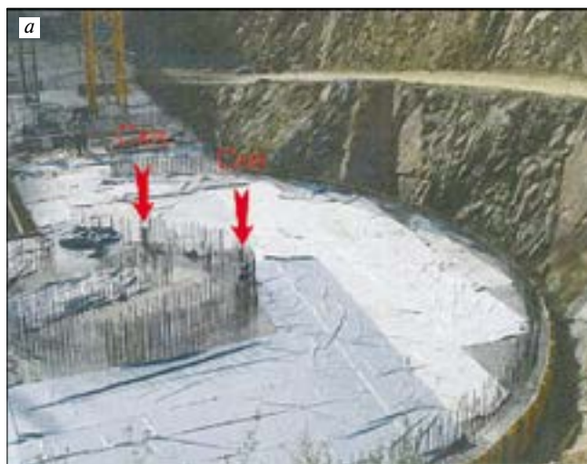
Рис. 3. Виды строительного котлована в габбровом массиве под четырехуровневый подземный паркинг «Башни Исеть»: а – западный борт (июль 2012 г.); б – восточный борт (сентябрь 2010 г.)
