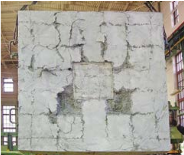
Рис. 3. Выкол бетона сжатой зоны в результате стесненного среза
