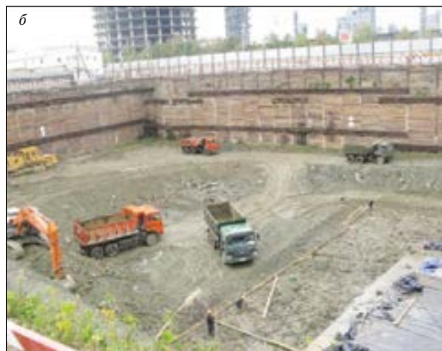
Рис. 3. Виды строительного котлована в габбровом массиве под четырехуровневый подземный паркинг «Башни Исеть»: а – западный борт (июль 2012 г.); б – восточный борт (сентябрь 2010 г.)
