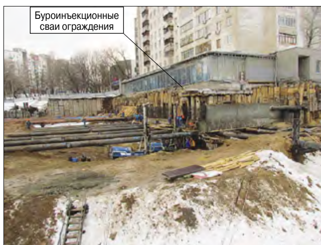
Рис. 1. Котлован и примыкающий к нему 10-этажный жилой дом
