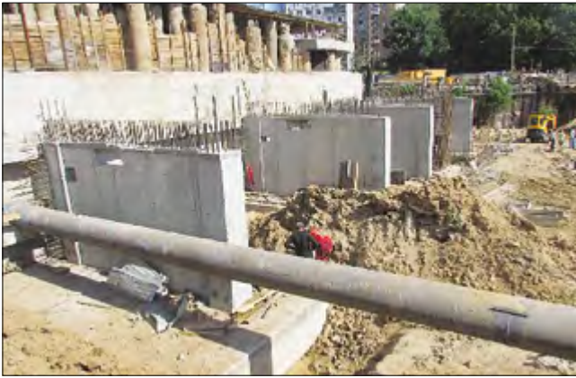
Рис. 7. Фрагменты выполненных контрфорсов
