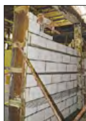
Рис. 5. Образец № 2 в процессе возведения внутреннего слоя из ячеисто-бетонных блоков
