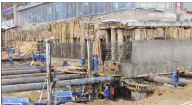
Рис. 3. Работы на узле 1 по усилению подпорной стены котлована
