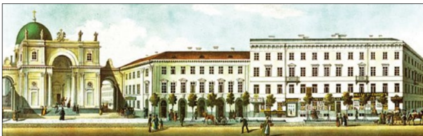
Рис. 9. Фрагмент панорамы Невского проспекта со зданием католической церкви Св. Екатерины. Арх. В. С. Садовников
