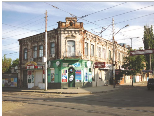
Рис. 7. Наружная реклама, вдобавок к неудовлетворительному состоянию фасадов здания, искажает зрительное восприятие экстерьера: угол ул. им. Горького и ул. Красноармейской
