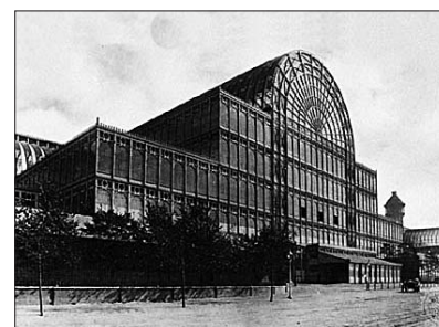
Рис. 3. Хрустальный дворец в Лондоне – пример строительства на основе модулей
