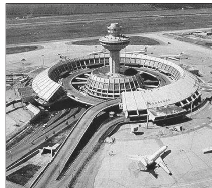
Рис. 4. Аэропорт Звартноц. Ереван, Армения, 1980 г. Арх. А. Тарханян, С. Хачикян, Л. Черкизян, Ж. Шехлян; инж. С. Багдасарян
