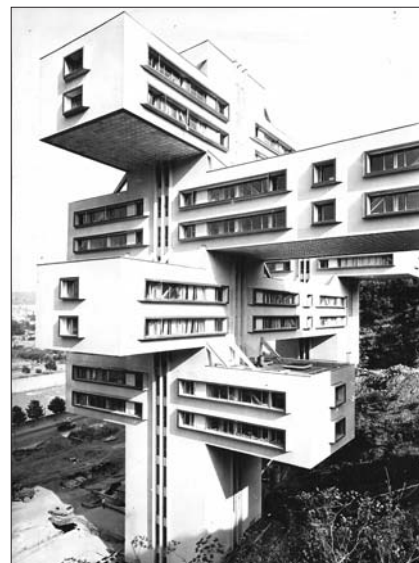
Рис. 3. Здание Министерства автомобильных дорог Грузинской ССР. Тбилиси, 1977 г. Арх. Г. Чахава, З. Джалагания; инж. Т. Тхилава, А. Кимберг
