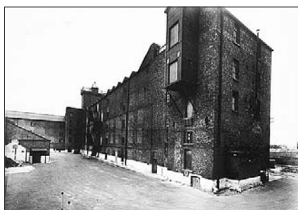
Рис. 2. Прядильная фабрика в г. Шрусбери. Первое здание с чугунным каркасом
