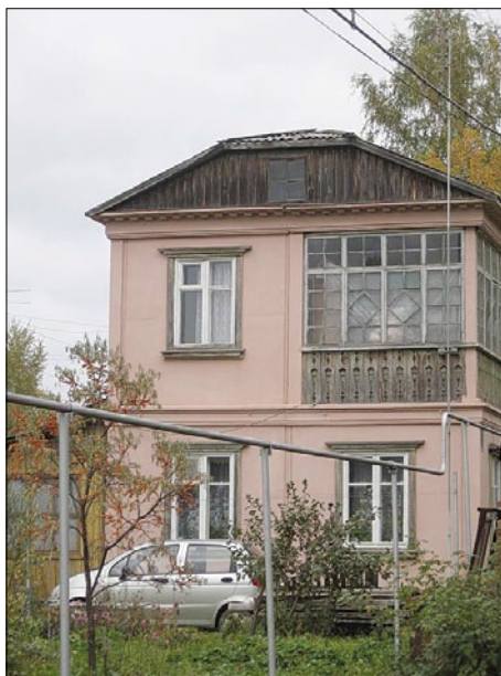
Рис. 2. Первый в СССР двухэтажный панельный жилой дом с неполным каркасом, г. Березовск, 1946 г. Архитекторы Г. Потапов и Г. Ростовская. (Первые панельные дома на Урале // Непарадный Сталианс. Малоэтажная городская архитектура СССР: [сайт]. URL: http://su-maloetazhki.livejournal.com/42708.html . Дата обращения: 13.05.2015.)
