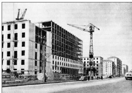
Рис. 5. Первый в СССР крупнопанельный бескаркасный жилой дом. Магнитогорск, 1951 г. (Первый в СССР крупнопанельный бескаркасный // Live journal: [сайт]. URL: http://vedmed1969.livejournal.com/532598.html . Дата обращения: 13.05.2015.)
