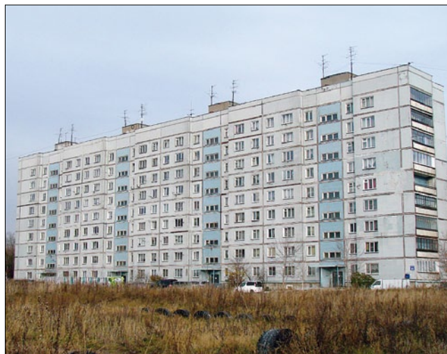
Рис. 7. Серия 90 крупнопанельных 9-этажных жилых домов. Разработана ЦНИИЭП жилища в 1972 г., арх. Н.П. Розанов (руководитель), В.И. Блюменталь (руководитель), В.О. Гринберг, А.П. Мокроусов, Я.А. Самойлова, А.О. Свешников, Л.Н. Алексеева, инж. А.Г. Розенфельд, Л.П. Витальев, К.А. Князева. (Типовая архитектура // Любимый город. История каждого дома: [сайт]. URL: http://wiki.darlingcity.ru/wiki/%D1%E5%F0%E8%FF_90 .)
