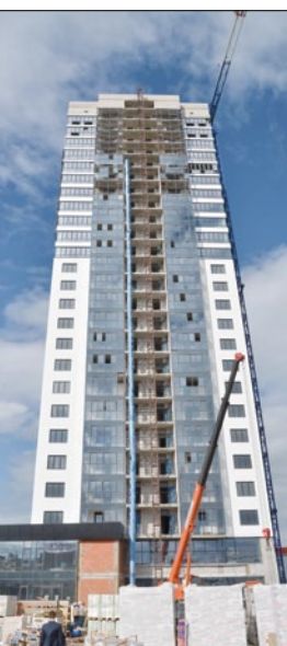
В настоящее время в Набережных Челнах строятся три новых 18-этажных каркасных дома с навесными панелями и 25-этажный каркасно-панельный дом. Полумиллионный «белый город на Каме» – Набережные Челны – застраивается целыми комплексами
