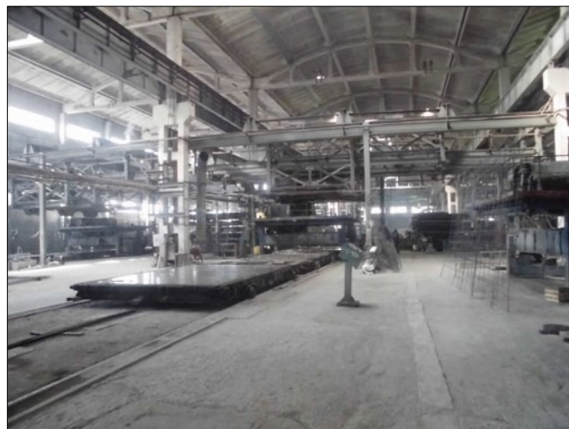
Рис. 2. Конвейерная линия по производству плит перекрытий (пролет «Б–В»)
