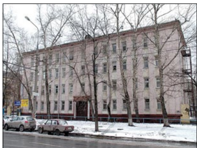
Рис. 3. Первый экспериментальный каркасно-панельный четырехэтажный дом. Москва, Соколиная Гора (проспект Буденного, д. 43), 1948 г. Арх. Б. Богомолова, инж. Г. Кузнецов. (Первые панельные дома // NoName: [сайт]. URL: http://nmm.me/blogs/kryaker41/pervyye-panelnye-doma/ . Дата обращения: 13.05.2015.)
