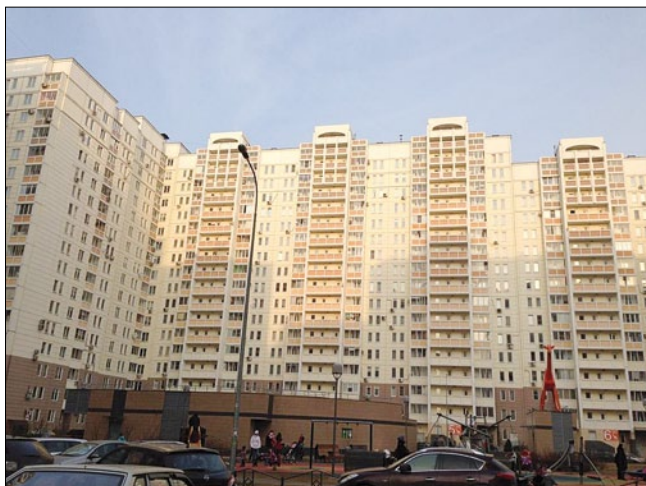
Рис. 8. Серия ГМС 1 крупнопанельных 17-этажных жилых домов. Разработана коллективом ЦНИИЭП жилища и Главмостроя. Арх. Ю.П. Григорьев, В.А. Чурилов, А.В. Крюков (в разное время) и др. (Серия ГМС 1 // АПБ 1: [сайт]. URL: http://www.apb1.ru/seriya-gms-01.html .)
