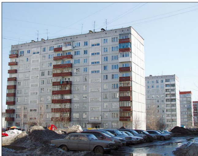
Рис. 6. Серия I-464 крупнопанельных 9-этажных жилых домов. Разработана Гипростройиндустрия в 1958 г., усовершенствованная ЦНИИЭП жилища (авторы проектов Н.П. Розанов, В.Г. Кошечков, А.Г. Розенфельд, И.П. Полозов). (Серия I-464Д // Народная база данных о многоквартирных домах «Правдом»: [сайт]. URL: http://pravdom.ru/k_seria.php?d=projekt_docs/s1-464d.php&s=8&r=99100 .)
