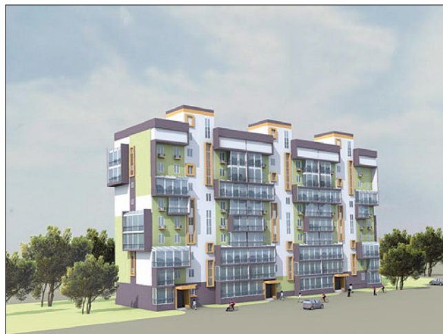
Рис. 9. Вариант 9-этажной крупнопанельной блок-секции в системе панельно-каркасного домостроения (СПКД). ЦНИИЭП жилища. Арх. Н.В. Дубынин, Е.В. Кашулина
