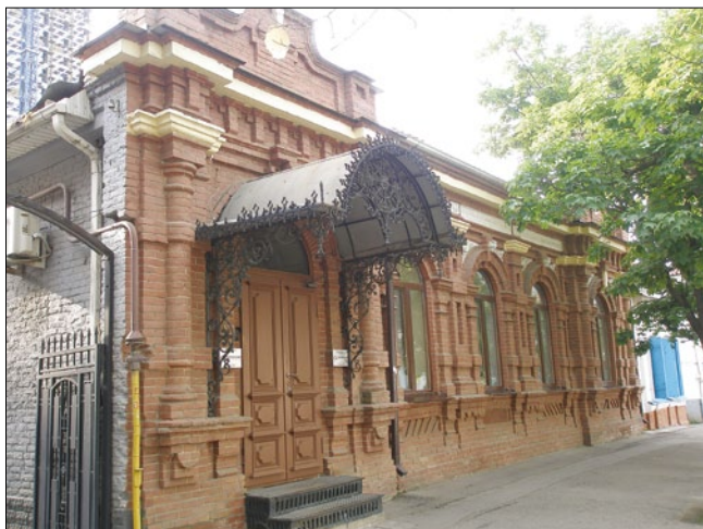
Рис. 2. Жилой дом начала XX в., ул. Красноармейская, 91
