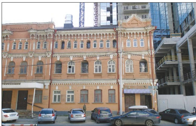
Рис. 8. Баня купца М.М. Лихацкого, ул. Длинная, 120, арх. Н.Д. Малама, 1893 г.; справа – строительство гостиничного комплекса «Марriott» (отсутствие необходимой охранной зоны от памятника архитектуры)
