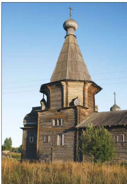
Рис. 5. Кокошники на церкви Иоанна Златоуста (1665 г.) в с. Саунино Архангельской области. Фото автора
