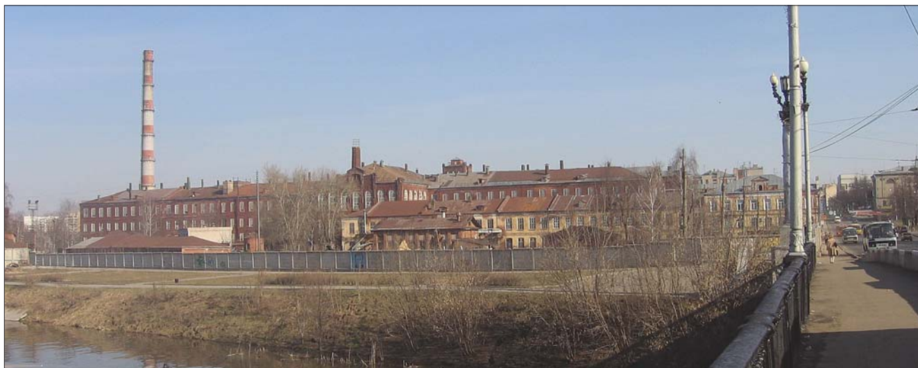
Рис. 3. Архитектурный комплекс отделочного производства фабрики Большая Ивановская мануфактура. Иваново
