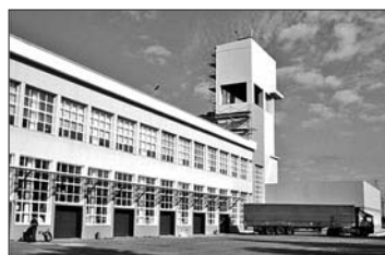
Рис. 17. Фабрика «Красная Талка». Общий вид
