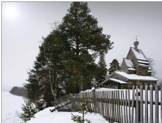
Рис. 1. Каскадные покрытия на Георгиевской церкви (1495 г.) в с. Юсковичи Ленинградской области. Фото П.В. Степанова
