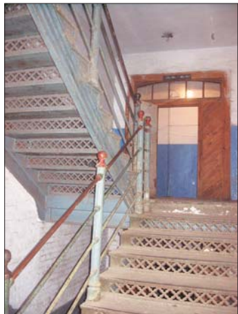
Рис. 10. Металлическая лестница в рабочей казарме фабрики Барановых в г. Карabanово Владимирской области
