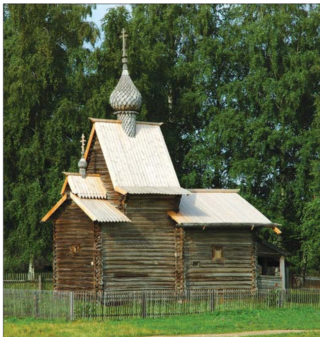
Рис. 2. Клинчатые с полцами покрытия церкви Ризоположения (1485 г.) из с. Бородава Вологодской области, перевезенной в Кириллов-Белозерский монастырь. Фото А.Ю. Пономарева
