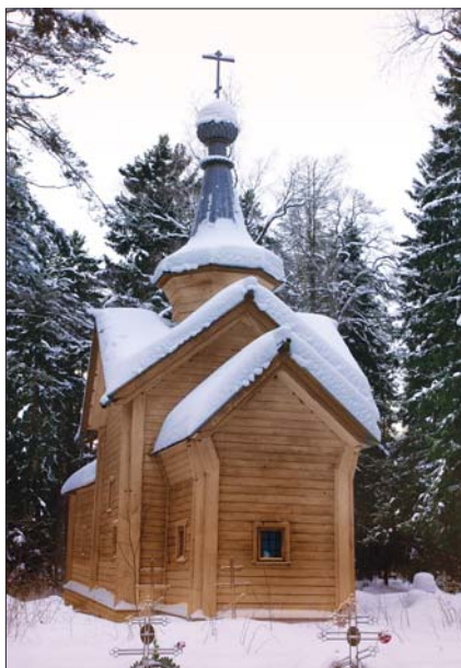
Рис. 6. Крещатое прямоскатное покрытие церкви Флора и Лавра (1613 г.) близ с. Мегрега (Карелия). Фото П.В. Степанова
