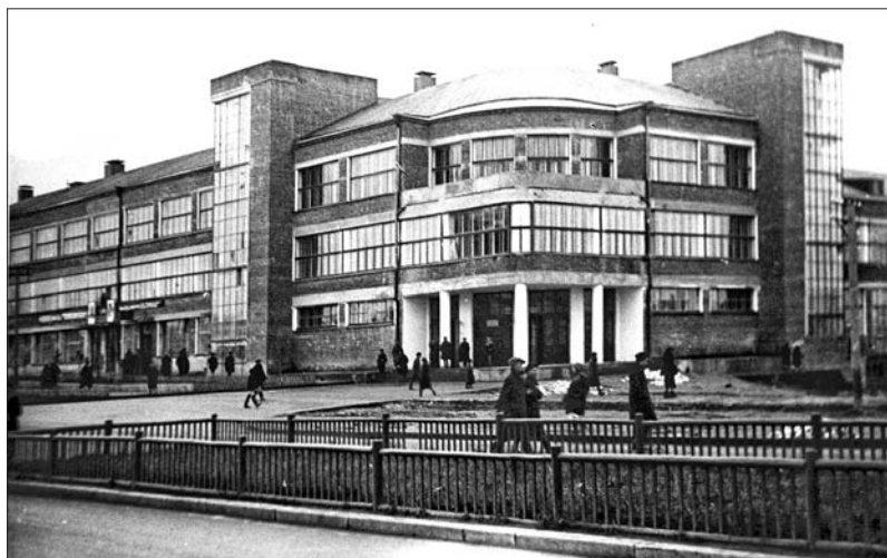
Рис. 9. Фабрика-кухня в Иваново-Вознесенске. 1933 г.
