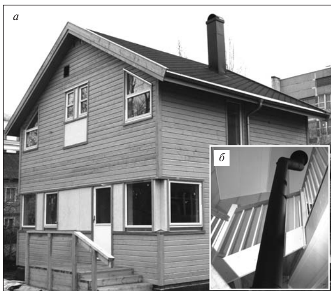
Рис. 2. Экспериментальный деревянный модульный дом с трубой, защищенной стальным кожухом: а – общий вид; б – сборная стальная дымовая труба с термоизоляционным слоем и обшивкой, огибающая деревянные конструкции
