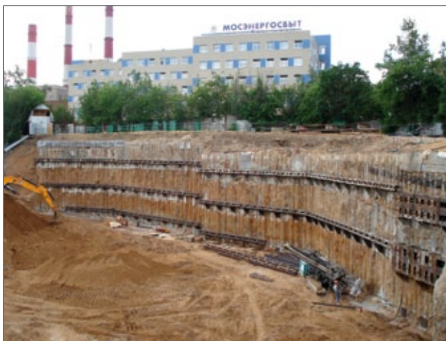
Рис. 6. Укрепление подпорной стены анкерами «Атлант»
