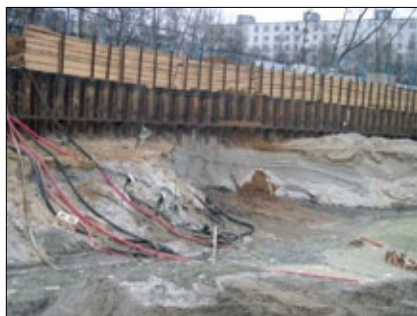
Рис. 10. Суффозия пригрузочной грунтовой бермы
