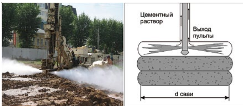
Рис. 2. Пример струйной цементации
