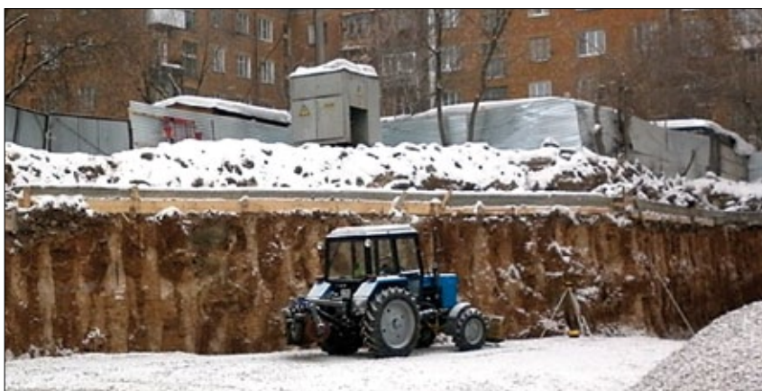
Рис. 3. Устройство ограждающей стены из секущих грунтоцементных свай
