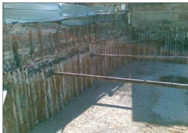
Рис. 5. Распорная система без распределительной балки
