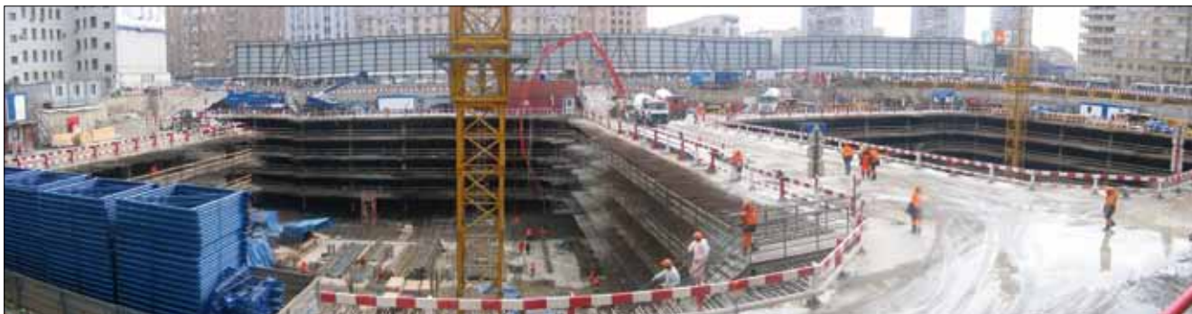
Многофункциональный торгово-деловой центр с подземной автостоянкой (Москва, Оружейный пер., 41)
