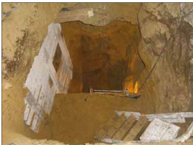
Рис. 8. Шурф глубиной 3,5 м для проверки закрепления грунта
