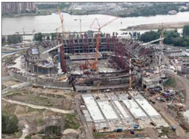
Устройство подземной части стадиона «Зенит» в Санкт-Петербурге
