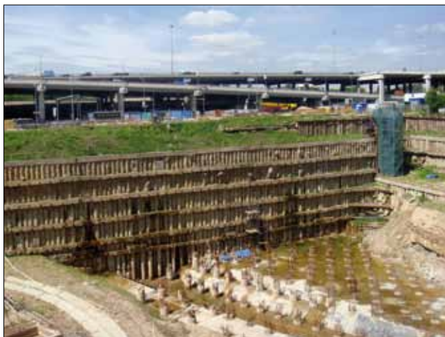
Стена в грунте при строительстве ММДЦ Москва-Сити
