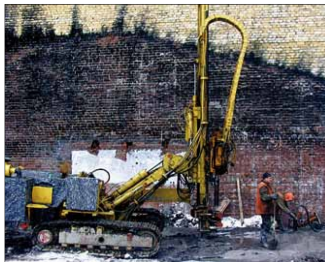
Рис. 2. Устройство буронабивных свай на участке примыкания к существующим зданиям старой постройки
