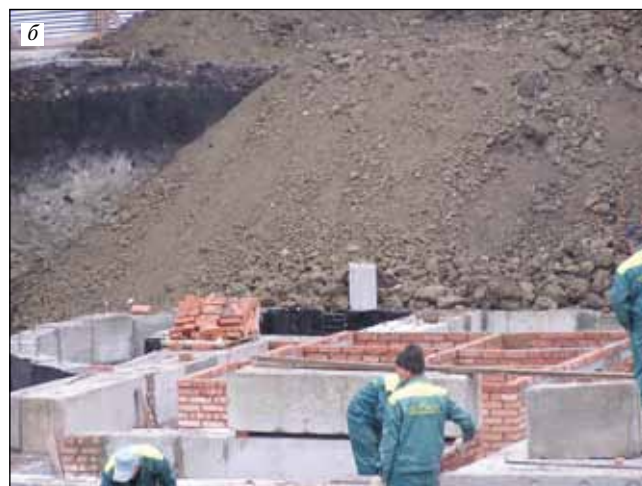
Рис. 4. Строительство нулевого цикла: а – котлован и устройство подбетонки под плиту; б – обрушение стены котлована при монтаже фундаментных блоков
