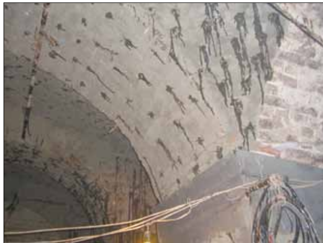
Рис. 13. Закрепление сводов инъекцией
