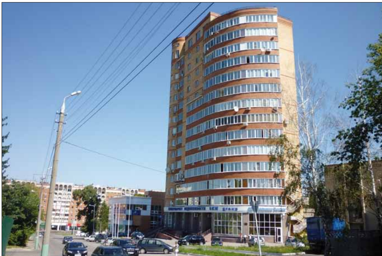
Рис. 1. Многоэтажный жилой дом с несущими стенами из кирпича
