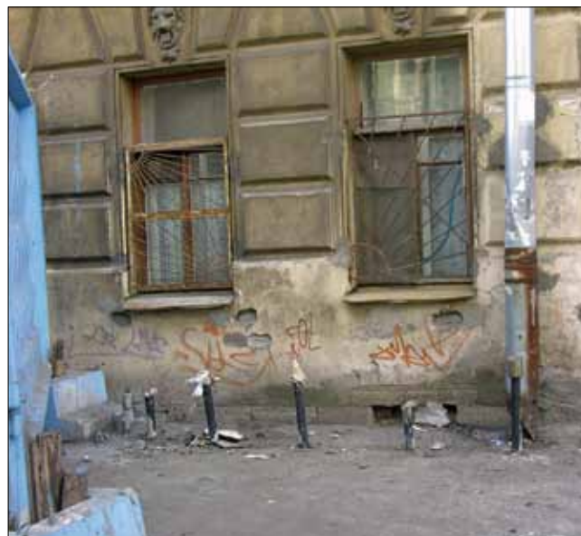
Рис. 4. Общий вид инъекционных трубок у закрепляемых фундаментах стен старого здания
