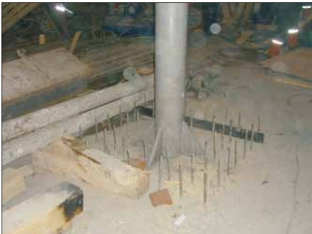
Рис. 12. Стальной сердечник для переноса нагрузки с перекрытий здания на фундаментную плиту
