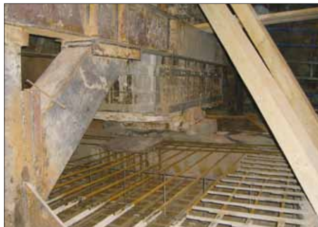
Рис. 10. Армирование фундаментной плиты под колонной в вывешенном состоянии
