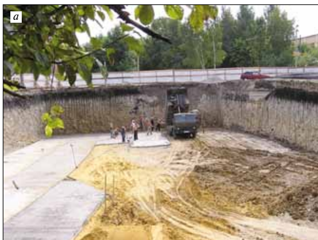
Рис. 4. Строительство нулевого цикла: а – котлован и устройство подбетонки под плиту; б – обрушение стены котлована при монтаже фундаментных блоков
