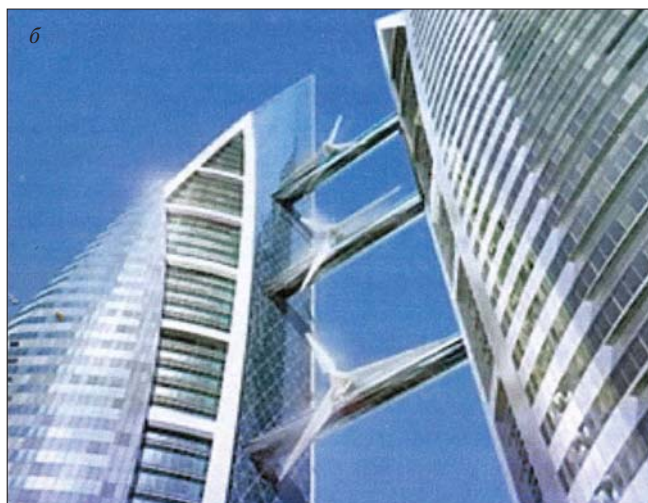
Рис. 5. Международный торговый центр (Манама, Королевство Бахрейн): а – общий вид; б – ветрогенераторы
