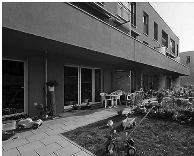
Рис. 2. Реконструкция жилого дома во Франкфурте (Германия). Индивидуальные дворики — «зеленые комнаты» квартир первого этажа. Архитектор С. Форстер
