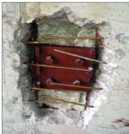
Рис. 4. Вид пружинного устройства перед обетонкой
