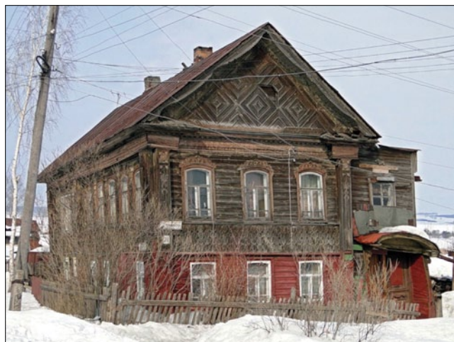
Рис. 8. Жилой дом в г. Цивильске
