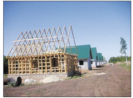
Рис. 4. Здания с деревянным каркасом в Оренбургской области
