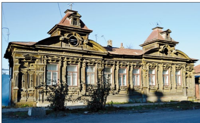
Рис. 1. Жилой дом в г. Цивильске
