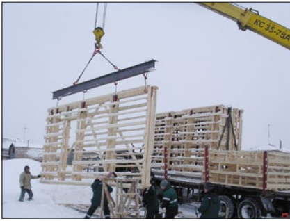
Рис. 2. Изготовленные в заводских условиях деревянные каркасы в Новосибирской области
