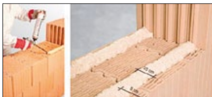
Рис. 2. Каменная кладка на пенополиуретановых швах
