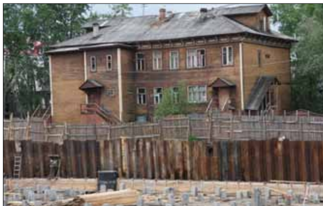
Рис. 6. Шпунтовая стенка вокруг котлована при строительстве нового многоэтажного здания вблизи традиционной деревянной застройки
