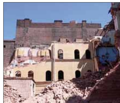
Рис. 10. Демонтаж конструкций внутри-дворовых флигелей
