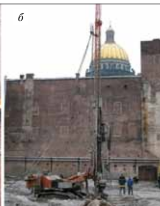
Рис. 12. Погружение шпунтового ограждения (а) и закрепление грунта по струйной технологии (б)
