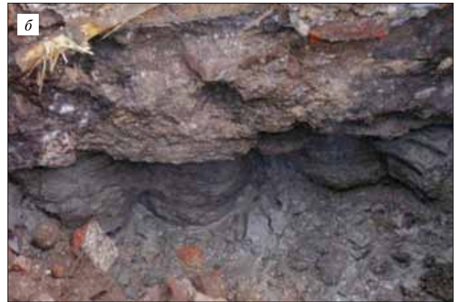
Рис. 11. Закрепление грунта под фундаментами окружающих зданий: а – размещение вертикальных столбов закрепленного грунта, армированных металлическими трубами; б – контрольное вскрытие шурфов
