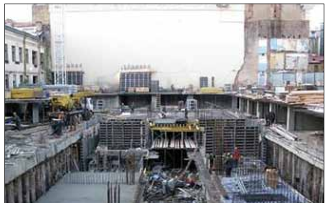
Рис. 13. Вскрытый котлован под паркинг-сейф
