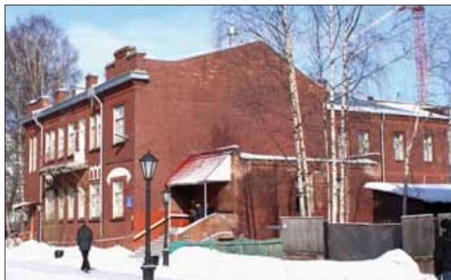
Рис. 4. Общий вид кирпичного дома — объекта культурного наследия со стороны ул. Чумбарова-Лучинского
