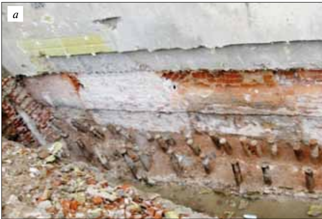
Рис. 11. Закрепление грунта под фундаментами окружающих зданий: а – размещение вертикальных столбов закрепленного грунта, армированных металлическими трубами; б – контрольное вскрытие шурфов
