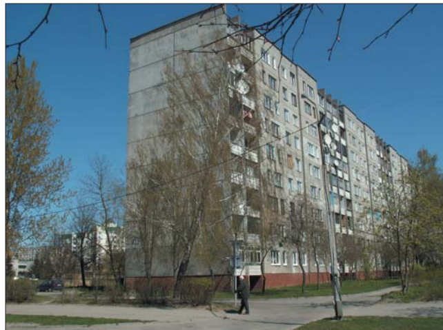
Рис. 2. Первый дом с наружными панелями из газосиликата на одну и две комнаты и высотой на этаж
