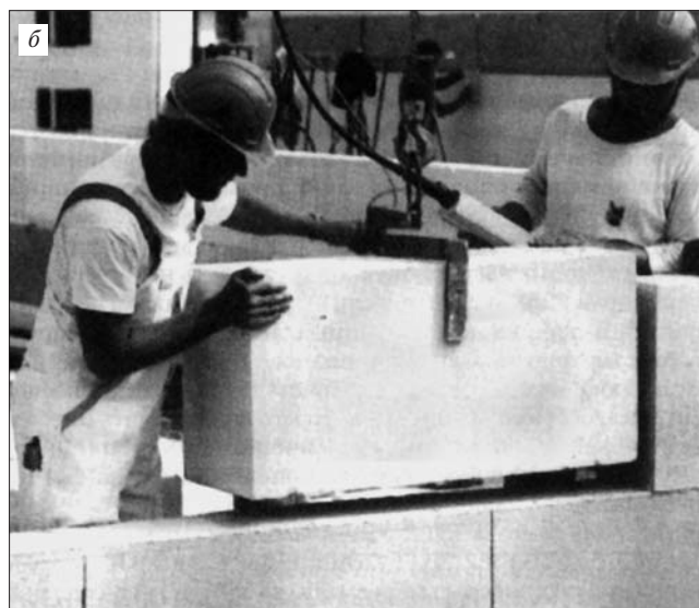
Рис. 3. Крупные ячеисто-бетонные блоки типа Jumbo (а) и их механизированный монтаж на строительной площадке (б)
