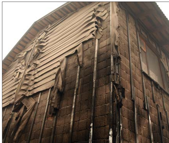
30 июля 2010 г., с. Передельцы Рязанского района Рязанской области. Село сгорело полностью, уцелели только два дома, построенные из керамзитобетонных блоков
