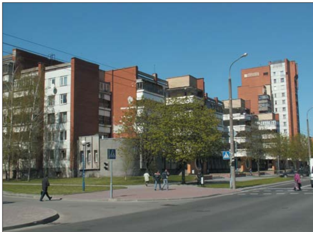
Рис. 1. Дома с несущими стенами из керамического кирпича и наружными стенами из газосиликатных панелей
