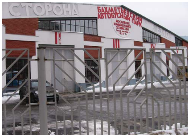
Рис. 5. Гараж для автобусов на улице Образцова архитектора К.С. Мельникова
