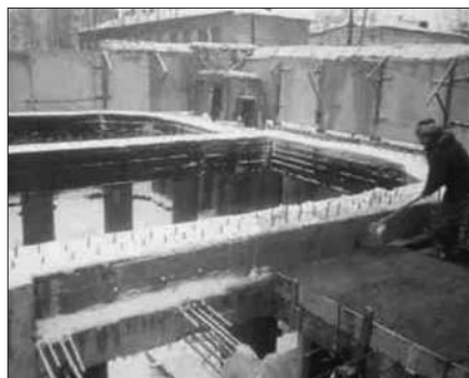
Рис. 1. Система сейсмоизоляции в виде сталебетонных СО, использованная при строительстве кирпичного жилого дома в г. Междуреченске Кемеровской области. 2004 г.
