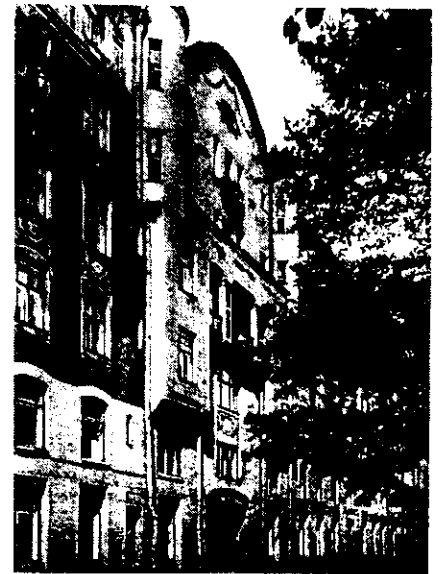
Доходный дом на М. Конюшенной, Санкт-Петербург. Архитектор Ф.Лидваль, 1905 г. Выделение центральной фасадной части со стороны улицы на высоту четырех верхних этажей объемом, выдающимся за плоскость фасада, и ограничение его боковыми эркерами
