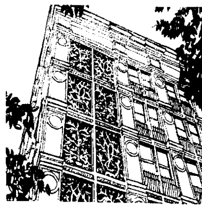
Фрагмент фасада жилого дома на Ленинградском пр. в Москве. 1941 г.
