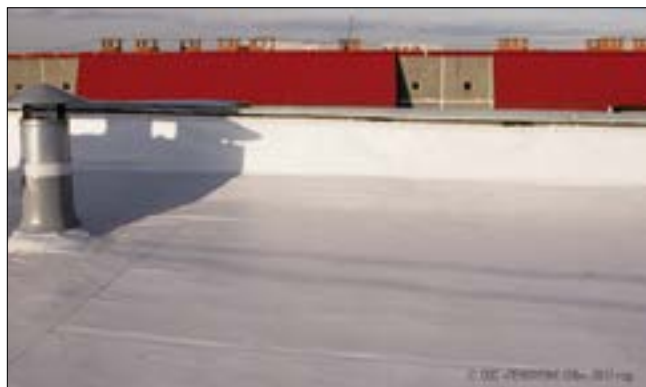
Рис. 2. Реконструкция старой битумной кровли без дополнительного утепления, г. Гатчина Ленинградской обл. Материал PLASTFOIL®
