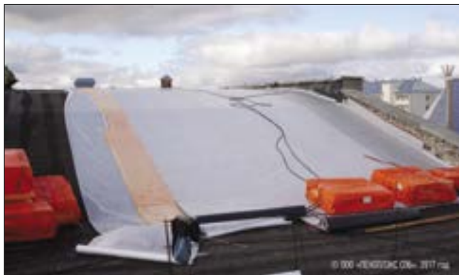
Рис. 4. Реконструкция старой битумной кровли с дополнительным утеплением, г. Нарьян-Мар. Материалы PLASTFOIL®, ПЕНОПЛЭКС®
