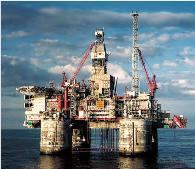
Рис. 1. Плавающая платформа Heidrun для добычи нефти, установленная на глубине 300 м в норвежском секторе Северного моря. Все элементы конструктивного каркаса платформы выполнены из легкого бетона класса по прочности LC60 (B70 – по ГОСТ 25820)
