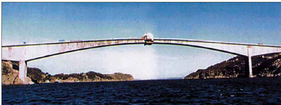
Рис. 2. Мост Stolmen (Норвегия) построен в 1998 г. (главный пролет 301 м). Центральная часть пролета 184 м выполнена из высокопрочного конструкционного легкого бетона на HF Леса 800; \rho = 1940 \text{ кг/м}^3 ; R_{28} = 70,4 \text{ МПа}
