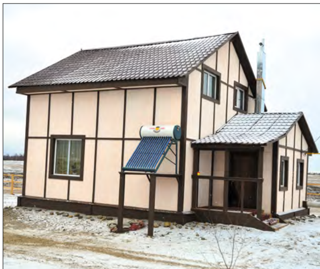
Рис. 2. Фасад жилого дома № 2 в с. Анпаны
