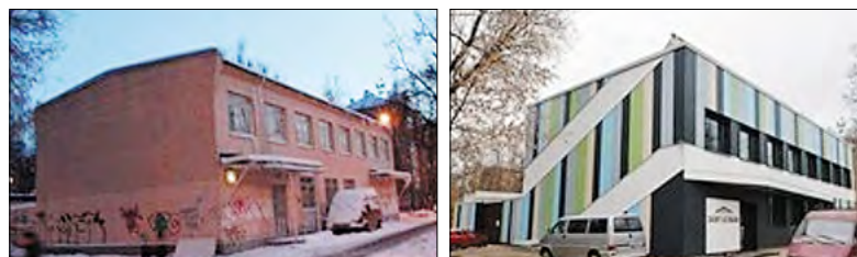
Рис. 1. Здание «Академии Сен-Гобен» до и после реконструкции.
