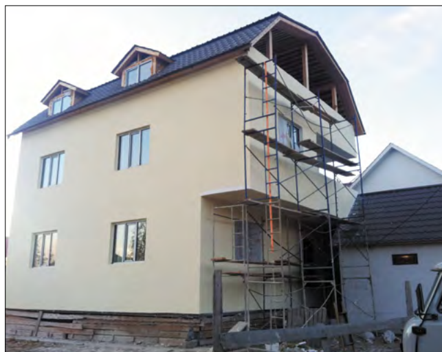
Рис. 4. Двухэтажный жилой дом в монолитно-каркасном исполнении в Якутске
