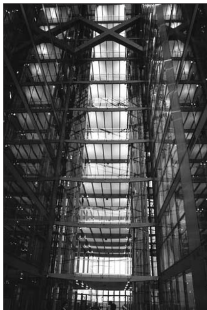
Рис. 3. Линейный атриум в офисном здании «Дойче пост» (г. Бонн, Германия, 1999 г.; арх. Х. Ян)
