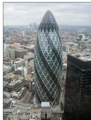
Башня Свисс Ре: высота 180 м, диаметр у основания 50 м, на уровне 16-го этажа — 56 м. Лондон, Великобритания (2004 г.)
