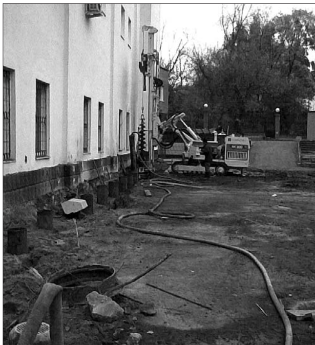
Рис. 8. Устройство свай с поверхности грунта
