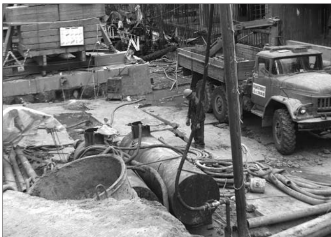
Рис. 12. Устройство скважин водопонижения
