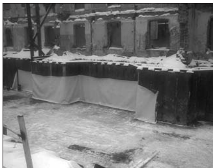
Рис. 10. Сохраняемая фасадная стена и ПВХ-гидроизоляция по шпунту
