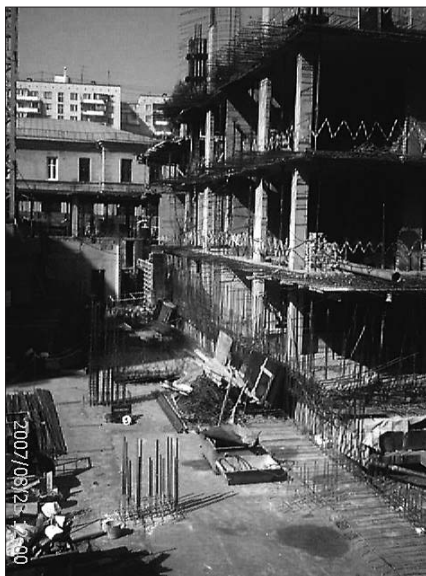
Рис. 11. Плита перекрытия над подвалом
