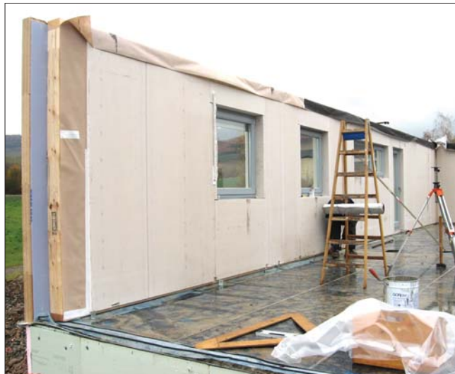
Монтаж панелей на объекте
