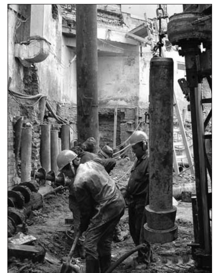
Рис. 5. Погружение шпунта пневмопробойником
