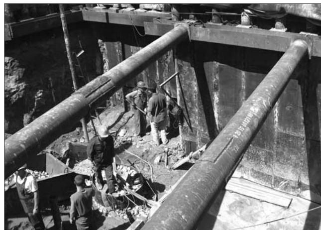
Рис. 13. Металлическая забирка по завесе закрепленного грунта
