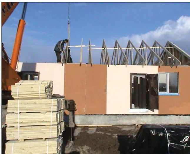
Строительство каркасно-панельного дома
