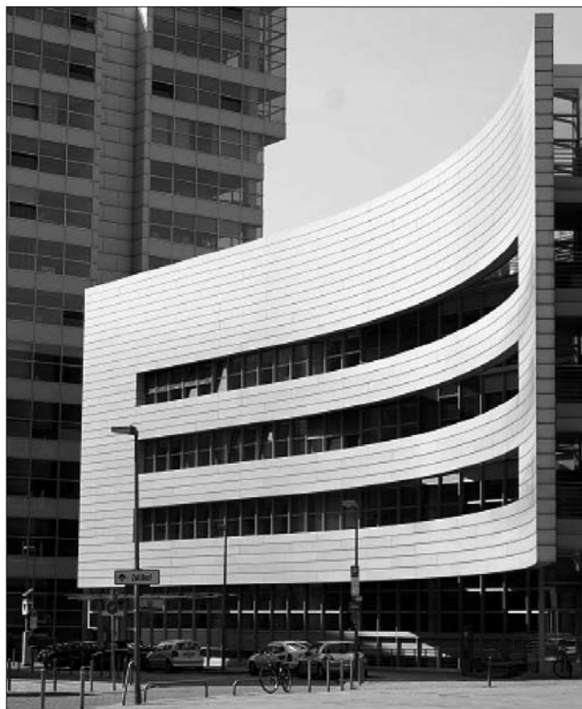
Рис. 2. Здание Центрального офиса дюссельдорфской пристани
