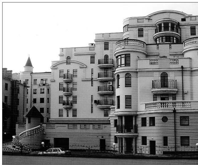
Облицовка открытых террас с балюстрадами и балконов фасада выполнена из полимергипсового материала «Столица»
