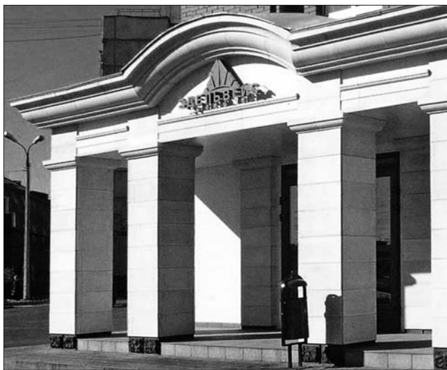
Створ колон портика и нижняя часть фасада облицованы плитками под белый камень из полимергипсового материала «Столица»
