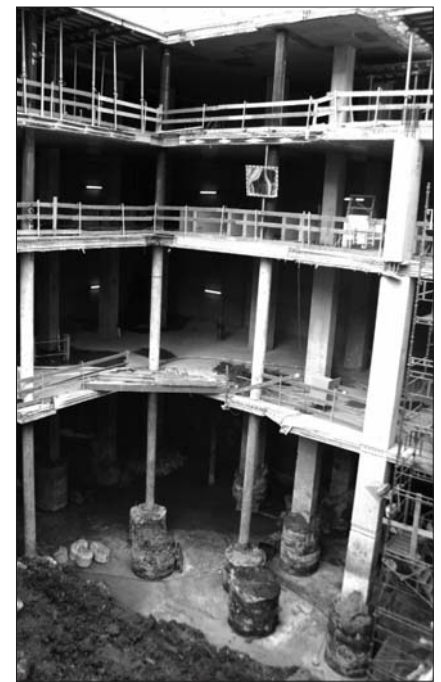
Рис. 6. Устройство временных и постоянных буровых колонн
