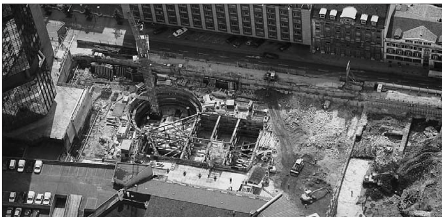
Рис. 2. Пионерный котлован с распорками при строительстве высотного здания Maintower во Франкфурте-на-Майне (вид сверху)
