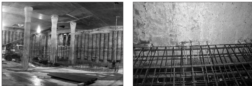
Рис. 4. Узлы соединения перекрытия и ограждения котлована
