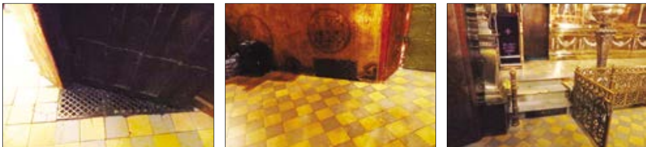
Рис. 7. Решетки отопления в полу, нижней части стены и в солее в Троицком соборе Сергиевой лавры
