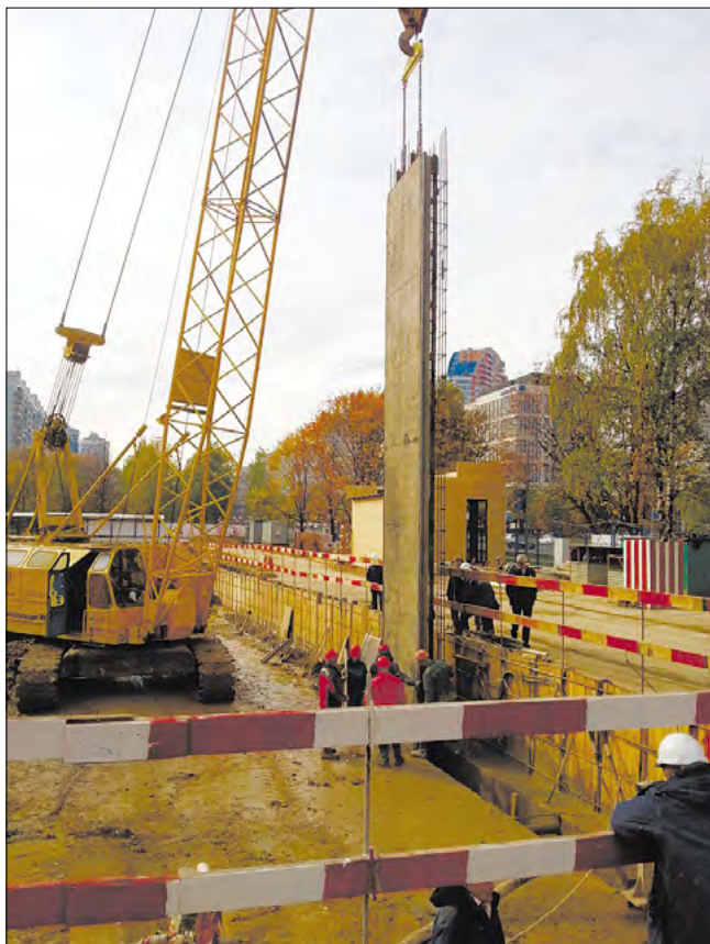
Рис. 1. Возведение «стены в грунте»
