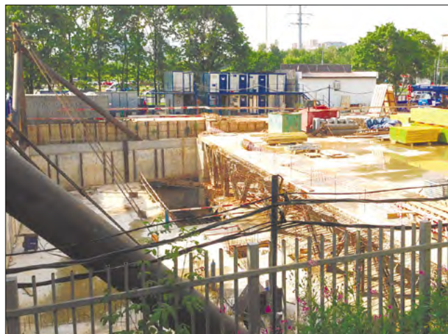
Рис. 2. Фермы и вантовые крепления, установленные при устройстве перекрытий подземной автостоянки
