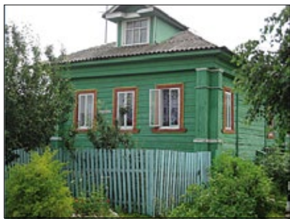
Рис. 2. Деревянный дом, г. Переславль-Залеский
