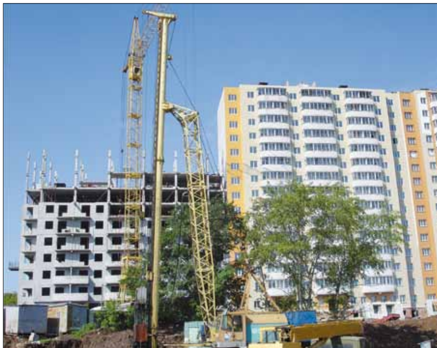
Массовая застройка 15-этажными жилыми домами с применением сборно-монокорпуса. г. Чебоксары. 2011 г.
