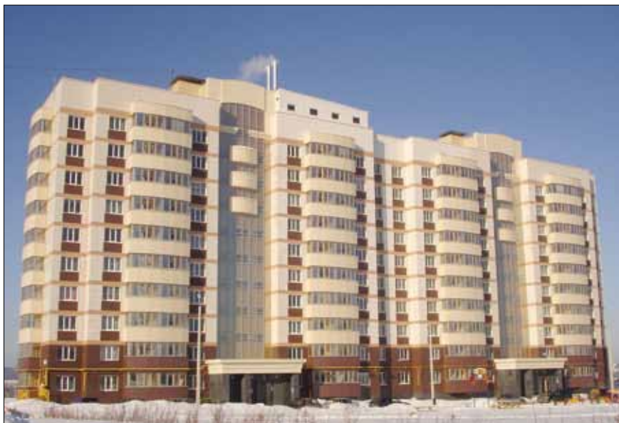
10-этажный жилой дом с 1–2-комнатными квартирами и автономной котельной на крыше, построенной с применением сборно-монокорпуса с пустотным настилом. г. Чебоксары. 2010 г.
