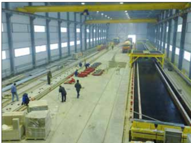
Завершение монтажа технологической линии «под ключ» по выпуску конструкций сборно-монолитного каркаса, 3-слойных «НС» с пустотным настилом a = 3,6 м мощностью 106 тыс. м 2 зданий в год. Калуга. ЗАО «Рекон». 2010 г.
