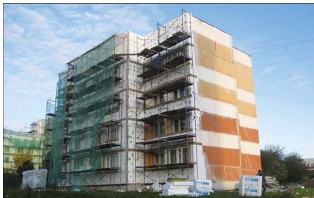
Утепление фасадов с помощью теплоизоляционных плит KNAUF Therm® Façade
