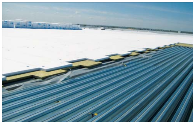
Использование теплоизоляции KNAUF Therm® Roof при устройстве кровли по профлисту
