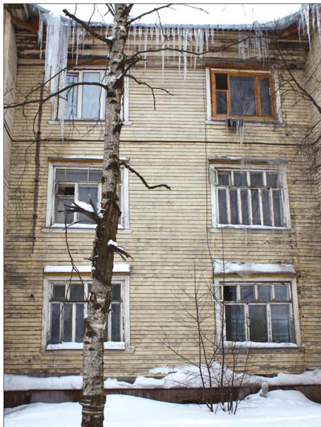
Части деревянных сооружений, наиболее подверженных увлажнению: а — увлажнение нижней части деревянных стен стекающими с крыши талыми водами; б — накопление снега и льда у нижних венцов вогнутой части здания
