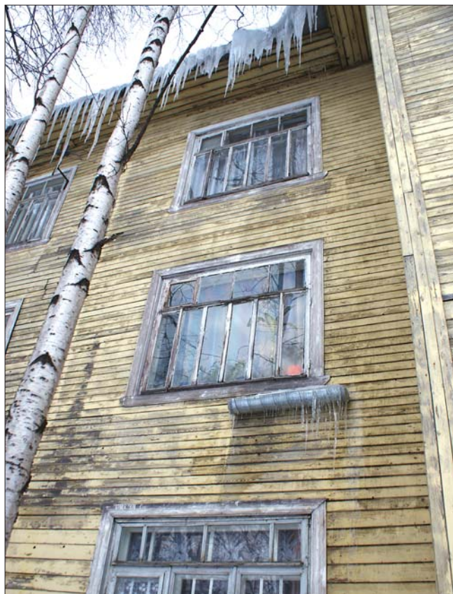
Части деревянных сооружений, наиболее подверженных увлажнению: а — увлажнение нижней части деревянных стен стекающими с крыши талыми водами; б — накопление снега и льда у нижних венцов вогнутой части здания
