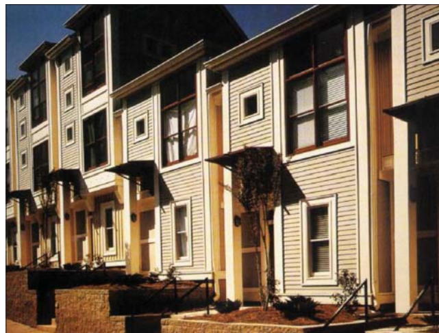
Рис. 5. Создание ритма в архитектуре жилого дома за счет расположения окон
