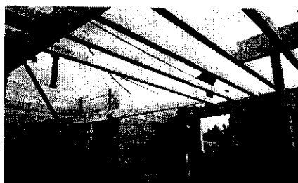
Монтаж балок перекрытия
