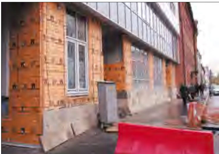
Схема теплоизоляции цокольного и первого этажа с применением плит ПЕНОПЛЭКС®
