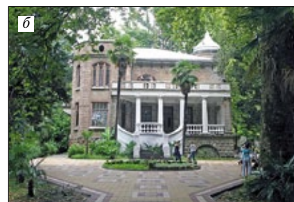
Рис. 4. Вилла «Вера»: а – первоначальный вид; б – современное состояние
