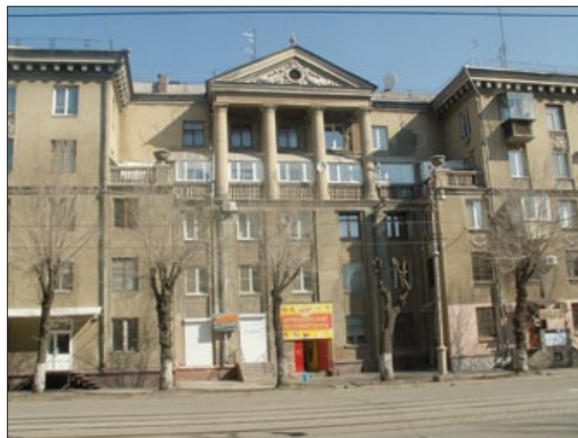
Фрагмент фасада жилого здания по ул. Ленинградской послевоенного периода
