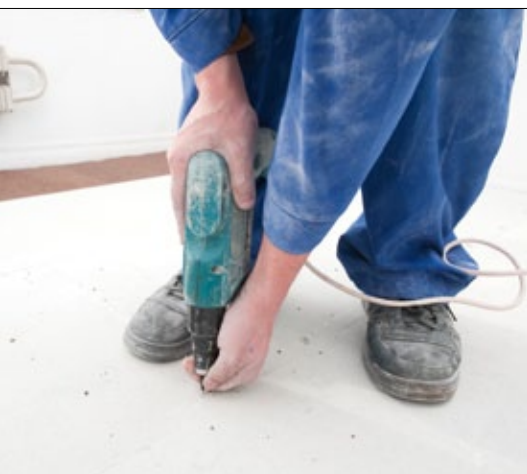
Крепление деталей стяжки между собой винтами
