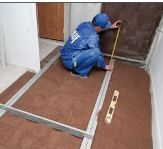
Нивелирование сухой засыпки
