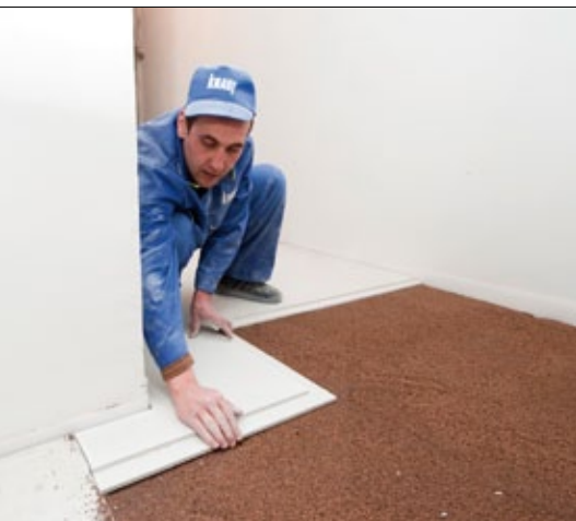
Монтаж элементов пола
