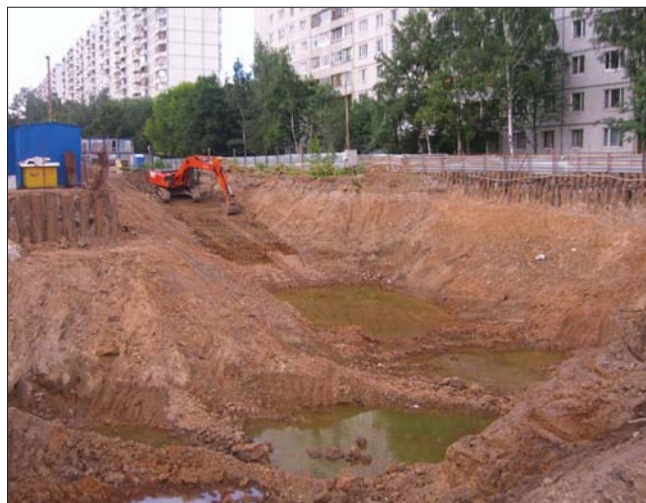
Рис. 8. Устройство пандуса, разработка грунта из центральной части котлована для устройства «пионерной» фундаментной плиты
