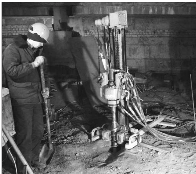
Рис. 3. Устройство буроньекционных свай
