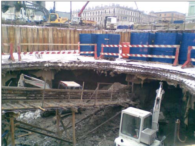
Рис. 4. Разработка грунта под железобетонной плитой ниже отм. -5 м
