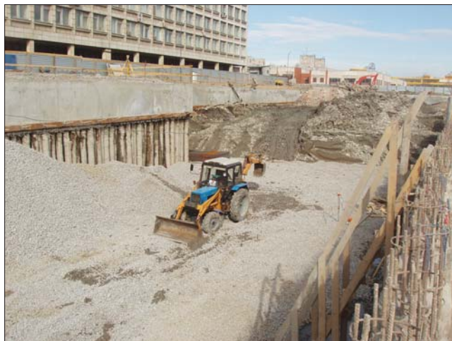
Рис. 11. Крепление стенок котлована при помощи анкеров (Санкт-Петербург, Московский р-н)
