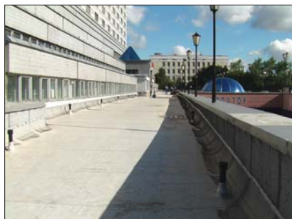
Рис. 1. Участок стилобата ГК «Берлин» с выполненным покрытием из Кровлелона с установленными по периметру аэраторами перед асфальтированием проезжей части
