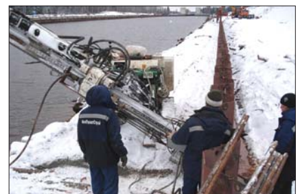
Рис. 3. Установка рабочих анкеров
