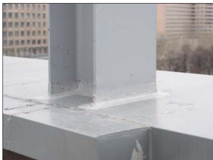
Рис. 5. Гидроизоляция основания стальной стойки мастикой Унимаст
