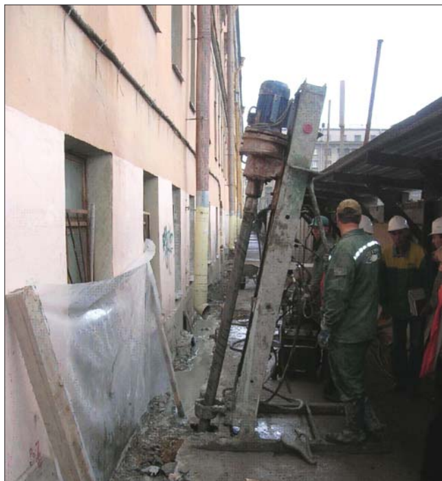
Рис. 8. Работы по бурению компенсационных скважин одного из домов по Минскому пер.
