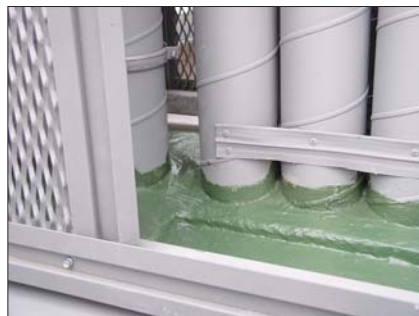
Рис. 6. Гидроизоляция вентиляционных выходов мастикой Унимаст
