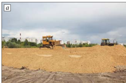
Рис. 1. Спортивный комплекс (Казань, ул. Маршала Чуйкова): а – земляные работы; б – монтаж конструкции; в – общий вид
