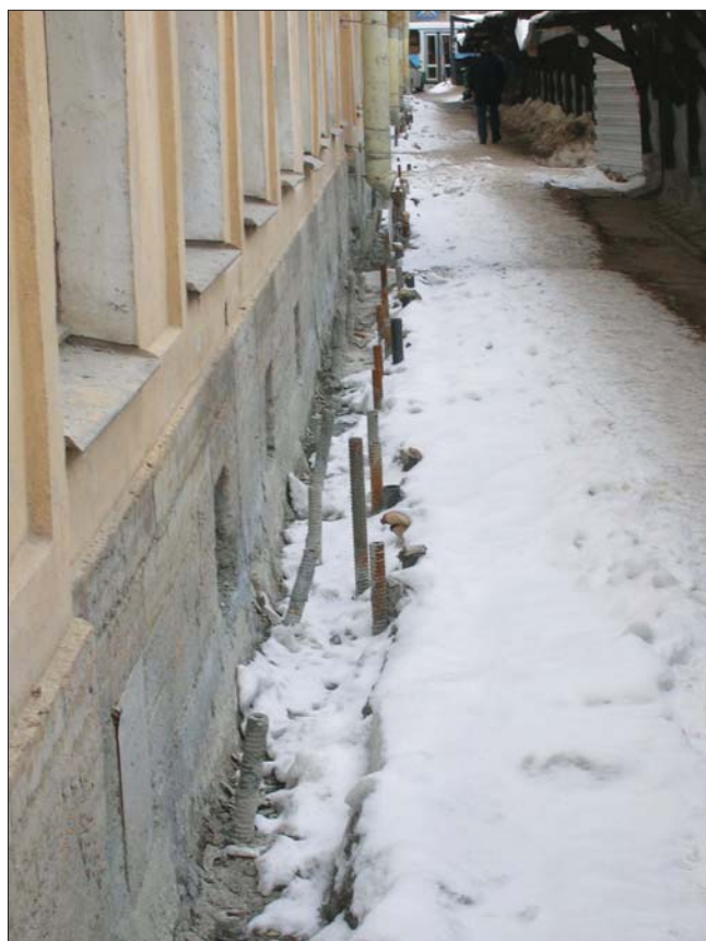
Рис. 10. Вид свай усиления «Titan» под фундаментом здания
