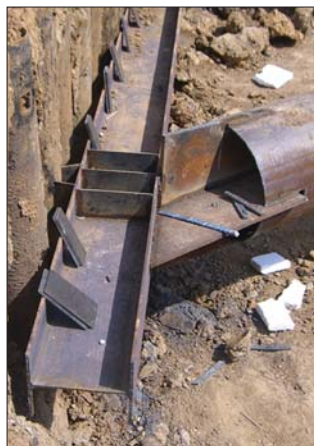
Рис. 5. Обвязочная балка первого яруса и сопряжение распорки
