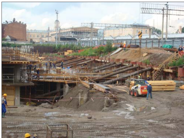
Рис. 10. Котлован с использованием подпорных конструкций (Санкт-Петербург, Лиговский пр.)
