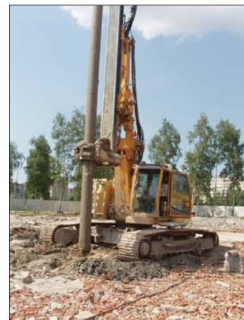
Рис. 9. Буровая машина RTG 21 фирмы Бауэр для устройства свай по технологии Double Rotary
