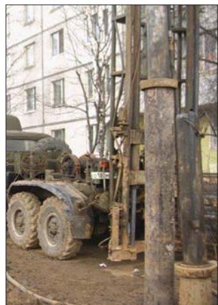
Рис. 4. Погружение труб пневмопробойником СО-166
