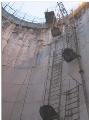
Рис. 8. Стены из секующихся буронабивных свай
