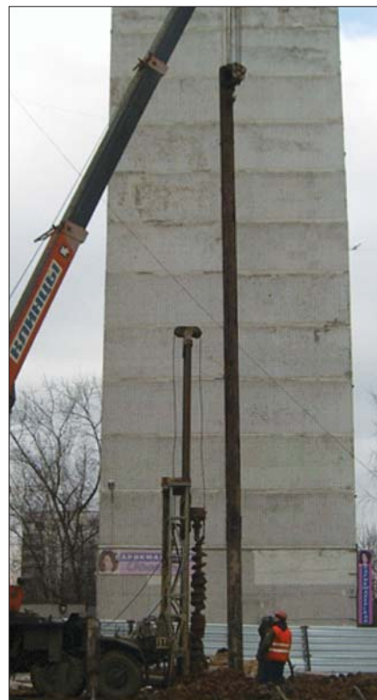
Рис. 3. Последовательное бурение скважины и установка трубы
