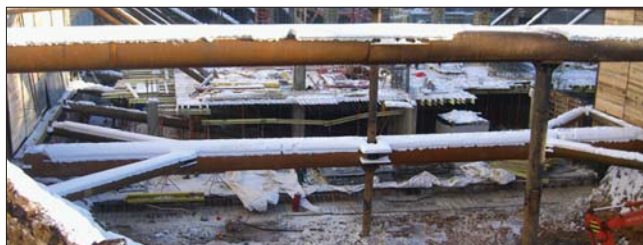
Рис. 6. «Вилочные» распорки в осях 9'–14'
