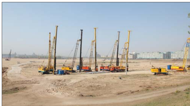
Рис. 2. Футбольный стадион на 45 тыс. зрителей (Казань, ул. Чистопольская): а – забивка свай; б – макет
