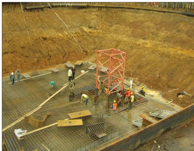
Рис. 9. Армирование «пионерной» фундаментной плиты и монтаж крана
