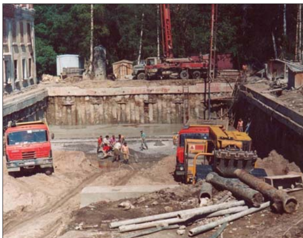
Рис. 7. Строительство подземного паркинга (Санкт-Петербург, ул. Пархоменко)
