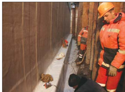
Рис. 4. Ведение гидроизоляционных работ в узких пазах между шпунтовым ограждением котлована и вертикальными железобетонными стенами заглубленной части многофункционального комплекса, расположенного на Ленинградском шоссе в Москве
