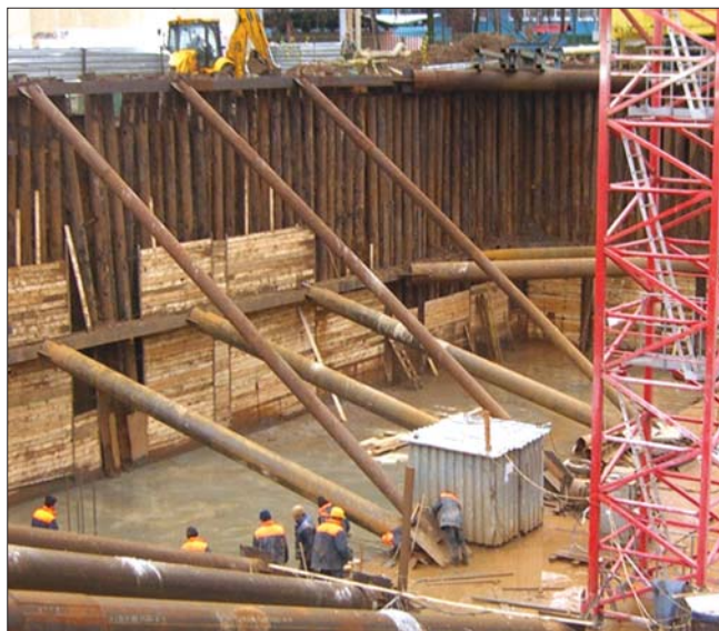
Рис. 10. Демонтаж распорной системы II яруса
