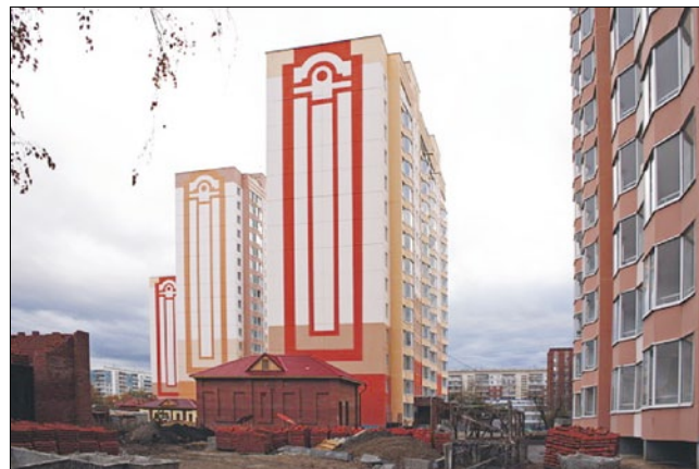
Рис. 2. Общий вид первого в Томске 17-этажного жилого дома. 2006 г.
