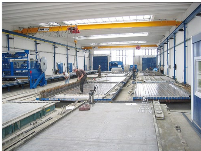
Рис. 6. Общий вид запускаемой в производство технологической линии изготовления железобетонных плит перекрытия в Томске
