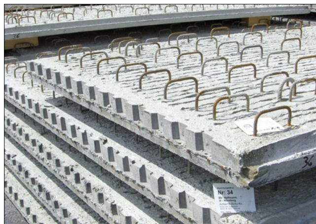
Рис. 2. Предварительно напряженные сборно-монолитные перекрытия
