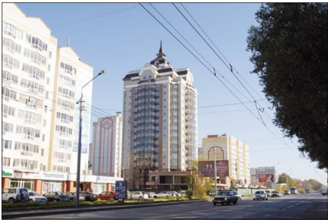
Рис. 9. Общий вид первого сборно-каркасного дома, построенного по системе «КАСКАД» в Томске. 2011 г.
