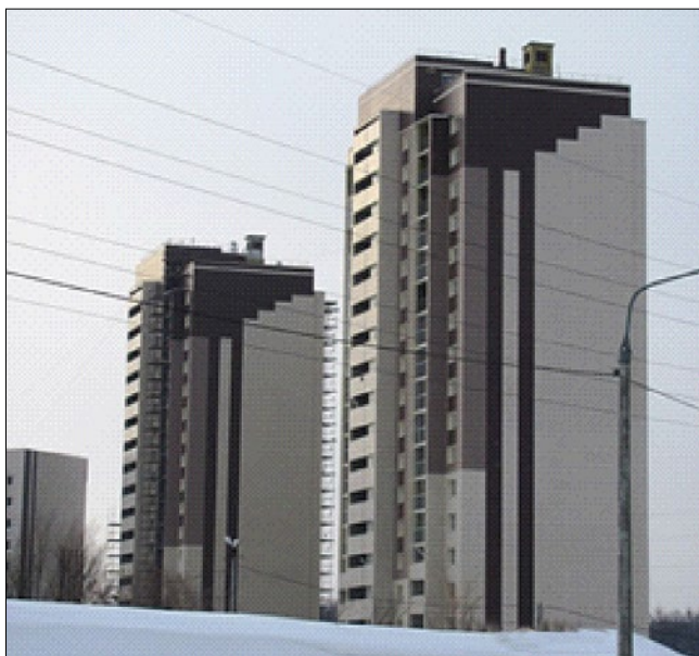
Крупнопанельные дома, построенные по проекту ЗАО «Казанский ГипроНИИавиапром»
