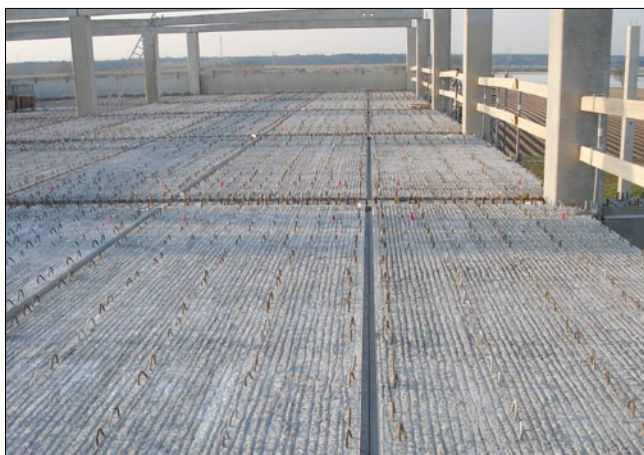
Рис. 1. Производственный корпус с предварительно напряженными сборно-монолитными перекрытиями
