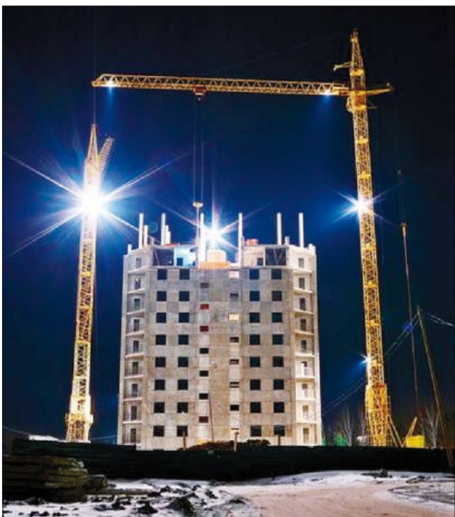
Рис. 10. Строительство в Томске каркасно-панельного дома по системе «КАСКАД». 2012 г.
