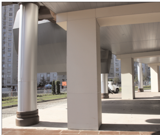
Рис. 4. Нависающая часть здания
