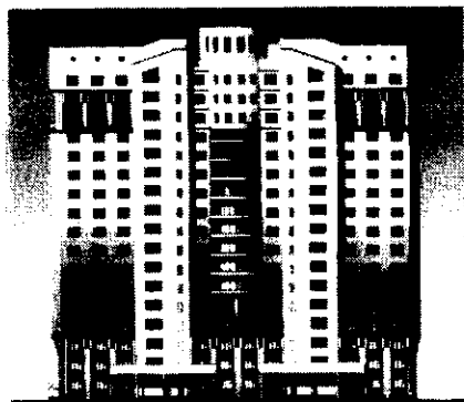
Кирпично-монолитный 17-этажный жилой дом повышенной комфортности, возведенный ЗАО "Жилстрой"
