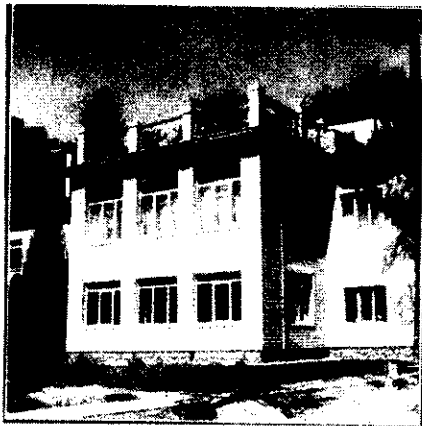
Коттедж, построенный жилищной ассоциацией "Раменье"
