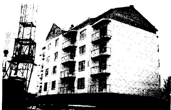
Строительство 194-квартирного жилого дома по технологии «Теплый дом»
