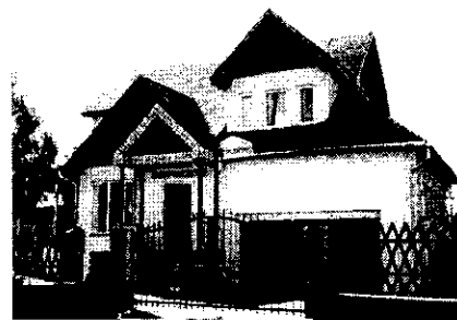
Коттедж из пенополистирола по технологии "ПЛАСТБАУ"
