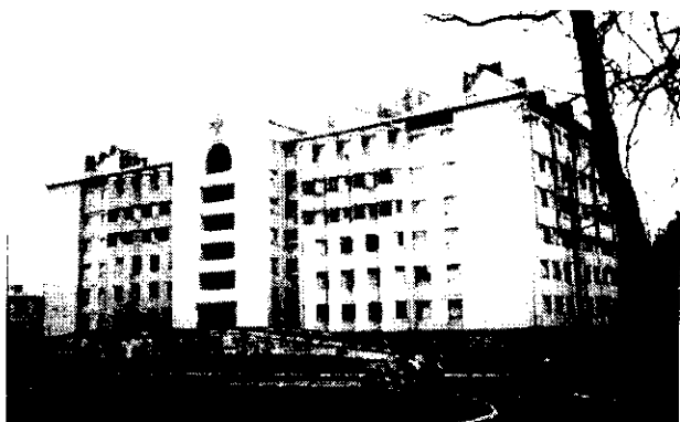
Строительство хирургического корпуса городской больницы в Йошкар-Оле
