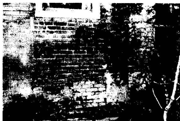
Рис. 2. Капиллярное увлажнение цокольной части здания
