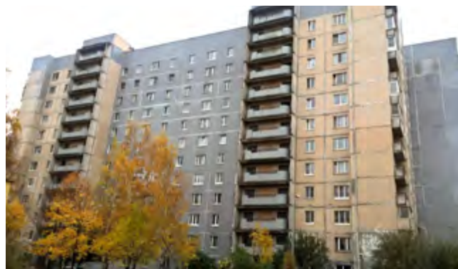
Рис. 4. Вид на здание по ул. Яхтенной, д. 4, к. 4
