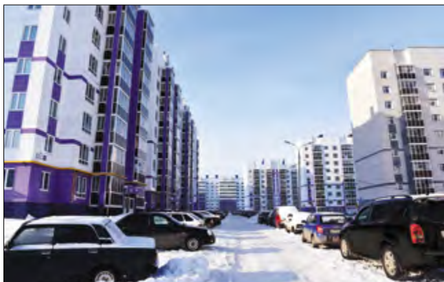
Мкр. «Финская долина», г. Чебоксары. Конструктив: КПД с многопустотными плитами перекрытия
