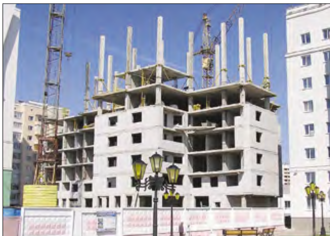
Рис. 1. Общий вид строящегося в Белгороде здания со сборно-монолитным «безригельным» каркасом
