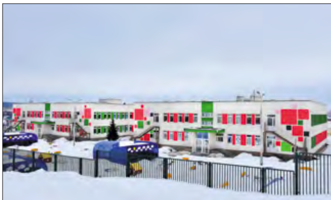
Дошкольное образовательное учреждение на 240 мест. Конструктив: КПД с многопустотными плитами перекрытия безопалубочного формирования
