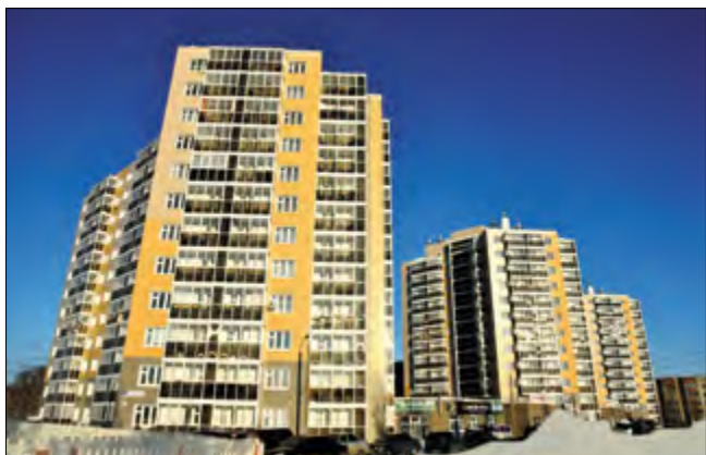
Позиция 1, мкр. «Речной бульвар», г. Новочебоксарск. Конструкция: ПКД с однослойными наружными стеновыми панелями под вентилируемый фасад
