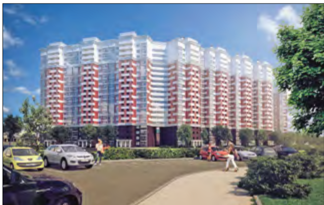
Жилой дом № 17/2 в ИК-9 мкр. «Солнечный город» в Казани. Конструкция: КППД с однослойными наружными стеновыми панелями под вентилируемый фасад
