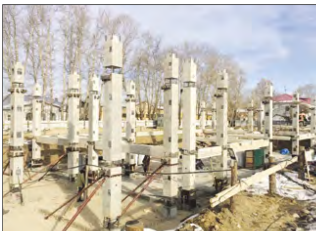
Рис. 3. Строительство жилого микрорайона
