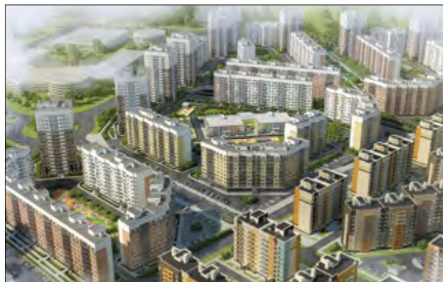
Застройка жилого района «Южный город», Самарская область. Конструкция: КППД с многоспустотными плитами перекрытия, однослойными стеновыми панелями под утеплитель со штукатуркой
