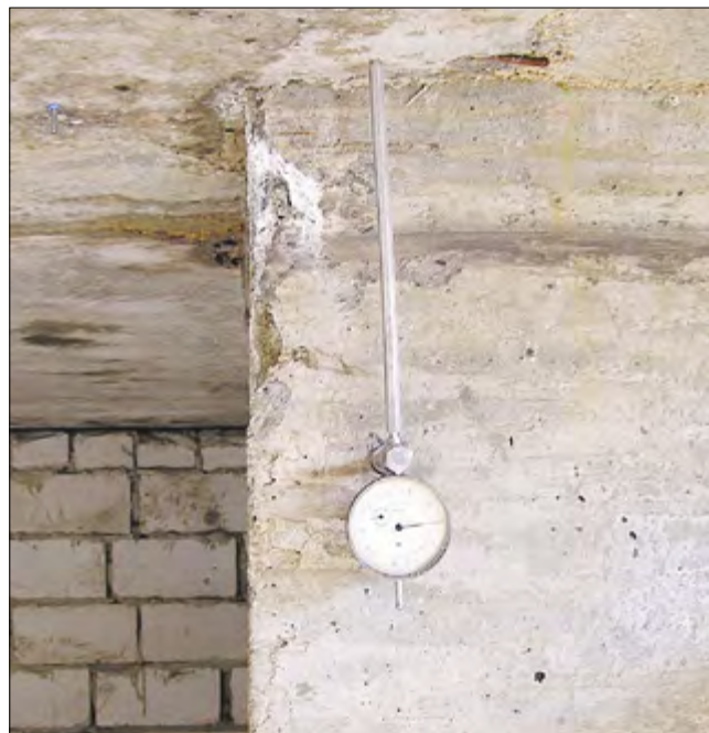
Рис. 3. Индикатор часового типа, измеряющий деформации узла сопряжения «ригеля» и колонны
