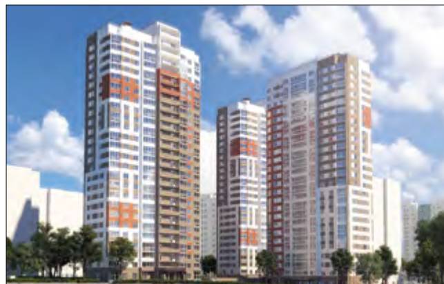
Мкр. «Серебряные ключи», г. Чебоксары. Конструктив: КПД с трехслойными наружными стеновыми панелями, облицованными клинкерным кирпичом
