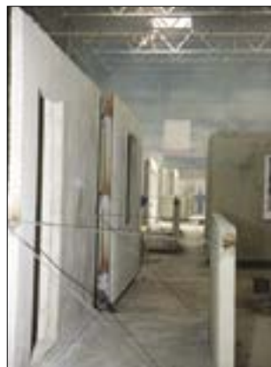
Рис. 19. Линия комплектации объемных блоков
