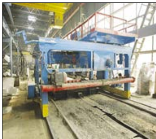
Рис. 22. Бетонукладчик конвейерной линии производства стеновых панелей СМЖ-166
