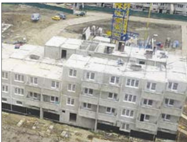
Рис. 6. Монтаж жилого дома
