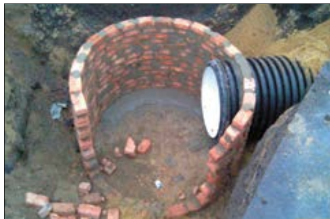
Рис. 3. Переходной колодец построенного канализационного коллектора в Советском районе г. Орла
