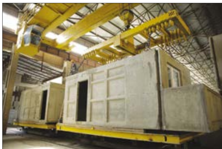
Рис. 8. Вывоз готового объемного блока на строительную площадку
