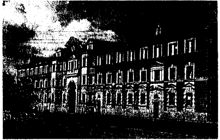
Трехэтажный жилой дом в проезде Бутырского хутора. Лауреат Сталинской премии архитектор Я.Г.Лихтенберг, 1948 г.
