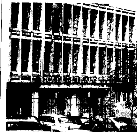
Здание администрации ЭП "Светлост"
